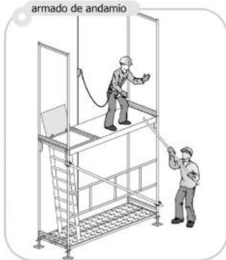
armado de andamio
