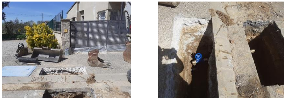
Actuació reparació de fuita.
