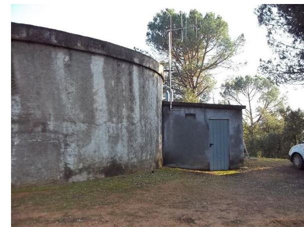
Imatge real del dipòsit.
