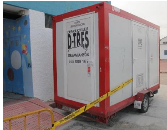
Sortida de la UMD per zona bruta o espai descontaminació
