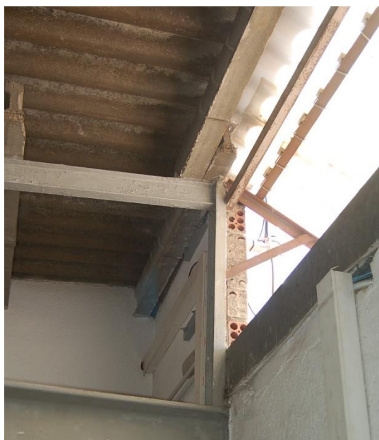
Detall estat ventilació i il·luminació Nau 1
