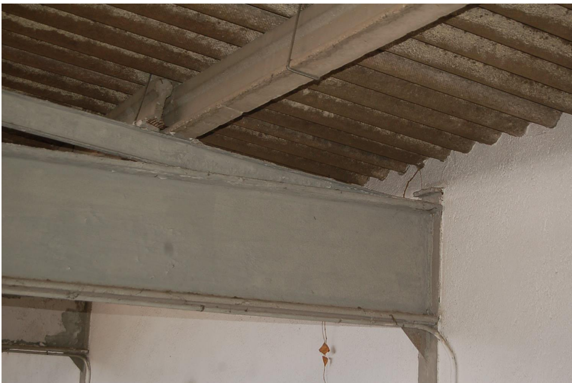
Estat actual de la coberta
