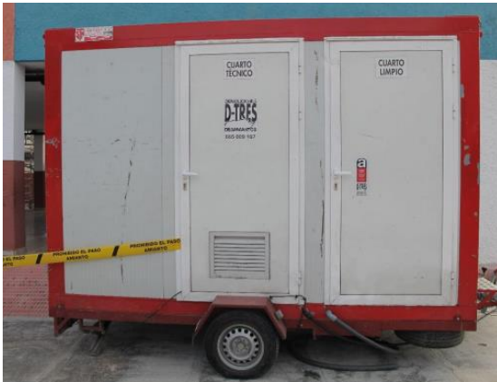
Entrada per espai net des de l'accés a l'obra
