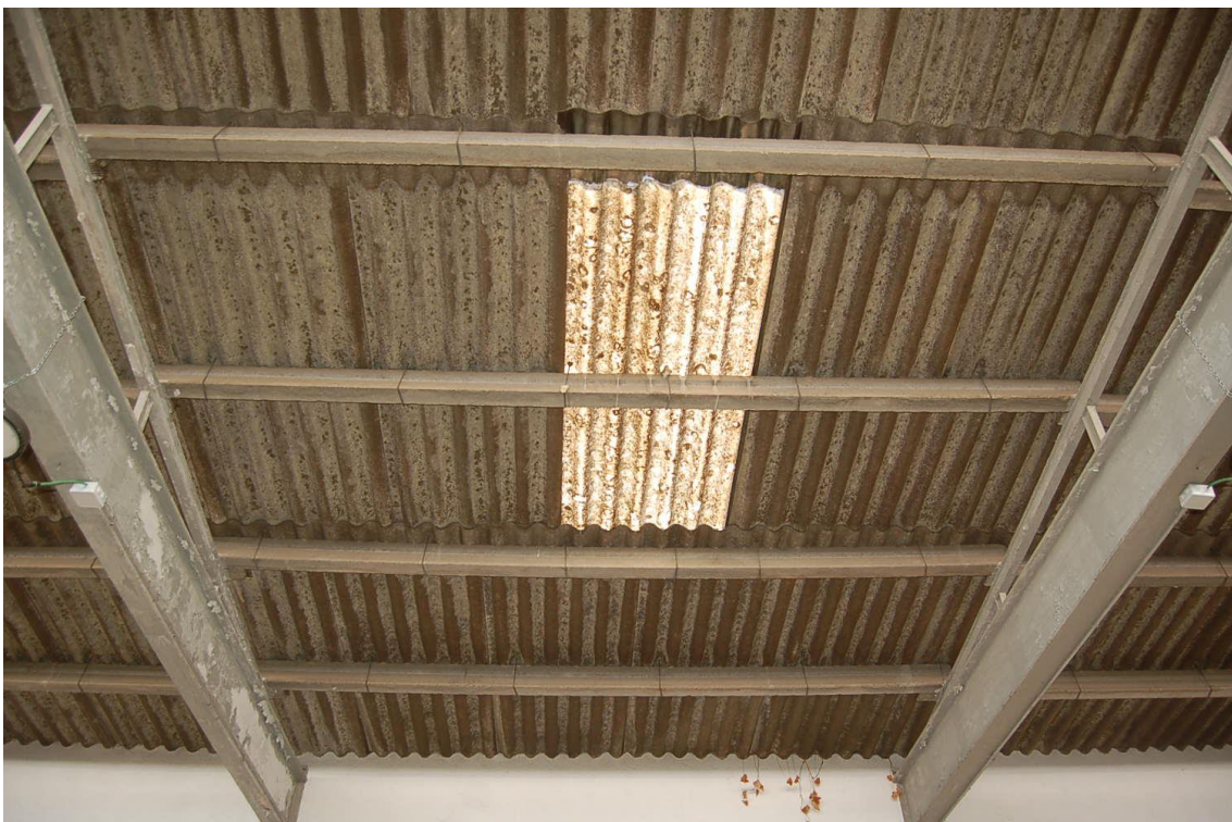
Estat actual de la coberta
