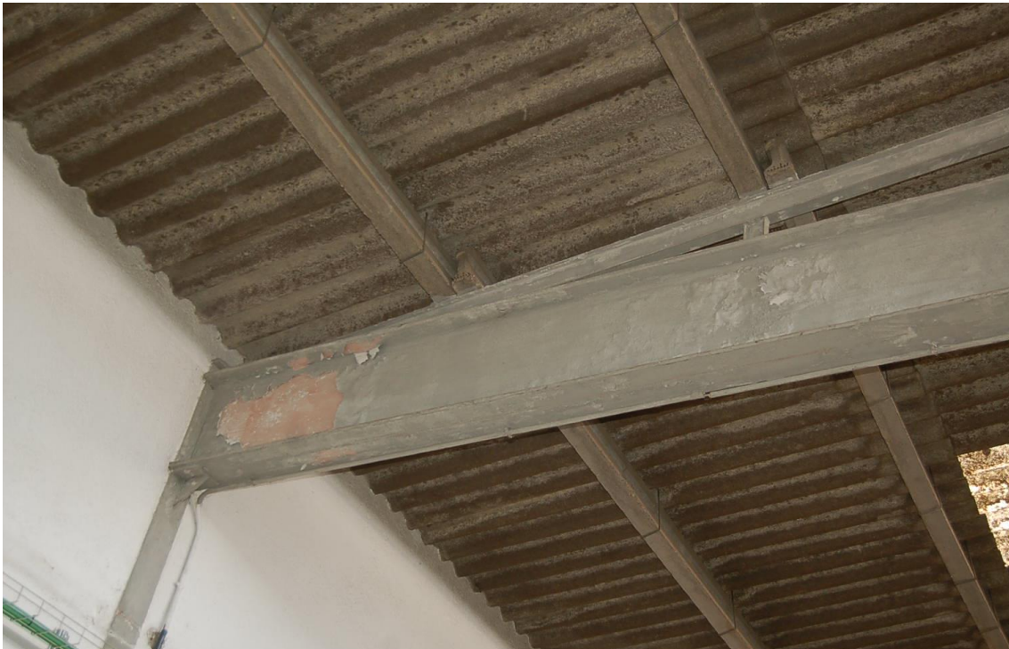
Estat actual de la coberta
