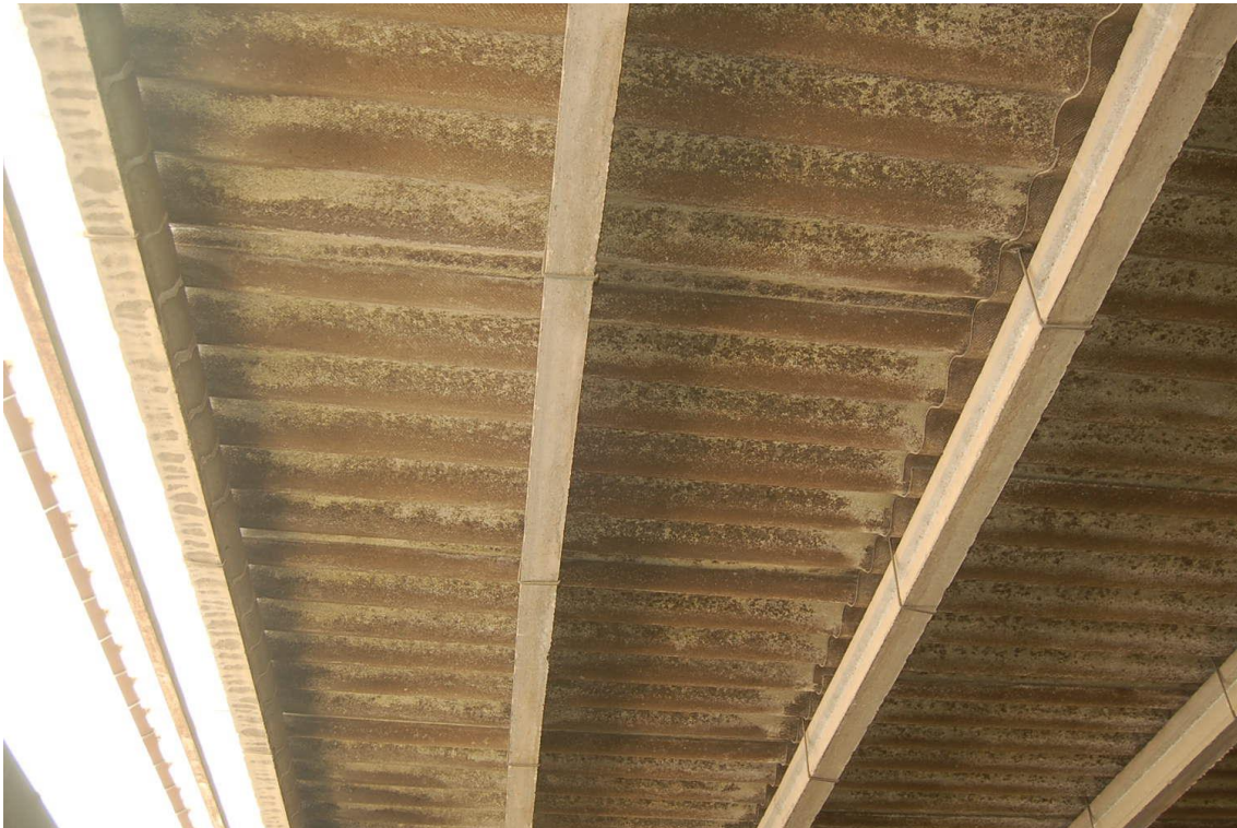
Estat actual de la coberta
