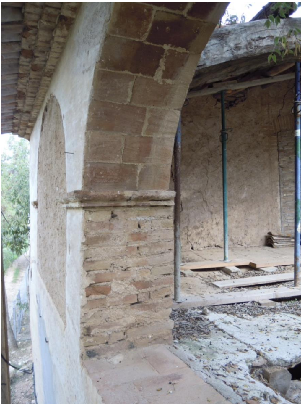
Detall de les obertures de les golfes i del ràfec.
