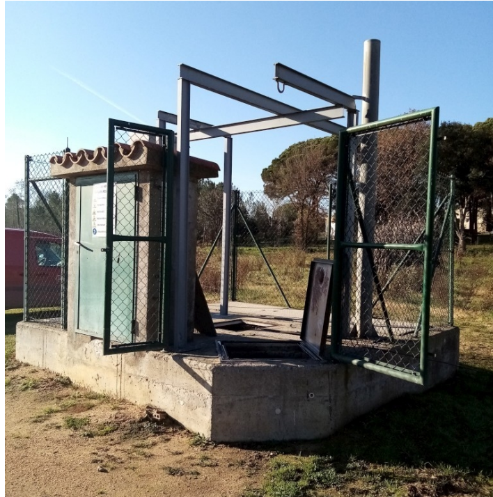
Foto 8 : Vista general de l'EBAR Mallorquines (TM Sils)
