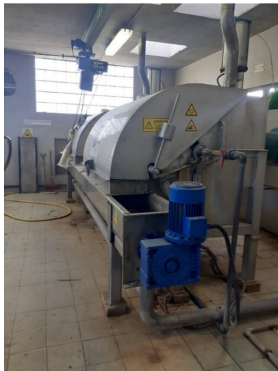
Foto 21 i 22: Vista general dels rototamisos i el cargol.
