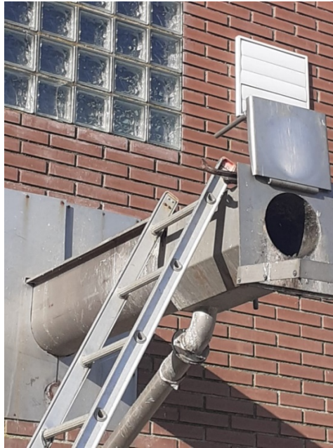
Foto 23: Tram final del cargol cap al contenidor
