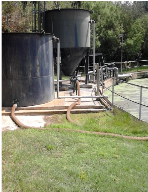
Foto 69: Espessidor de fangs actual.
