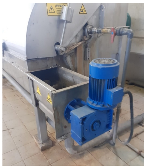
Foto 21 i 22: Vista general dels rototamisos i el cargol.
