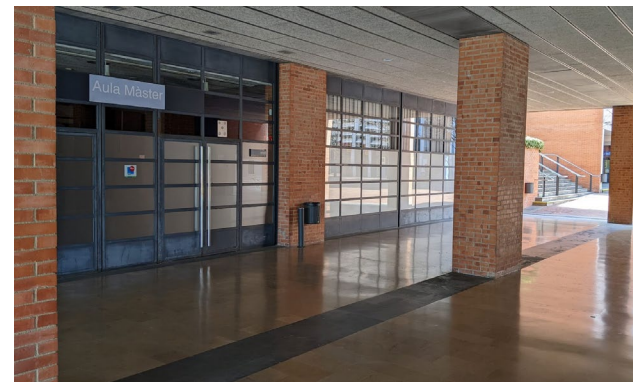
Vista de l'accés al vestíbul de l'Aula Màster
