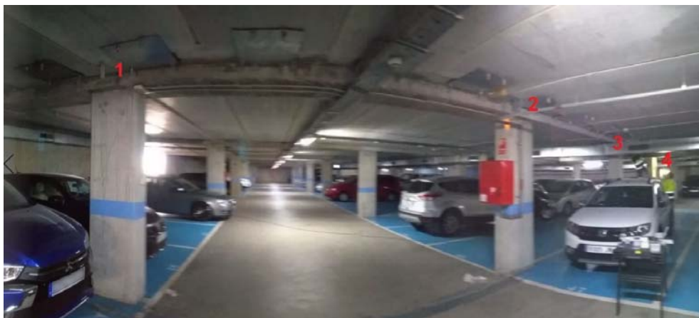
Imatge 24: Vista de la ubicació de les plaques de reforç inicials
