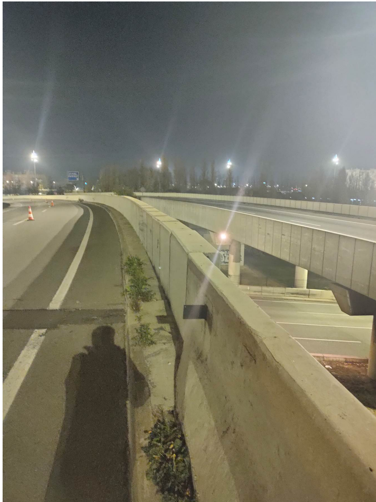
Imatge 19. Element de contenció en viaductes al Nus de la Trinitat.
