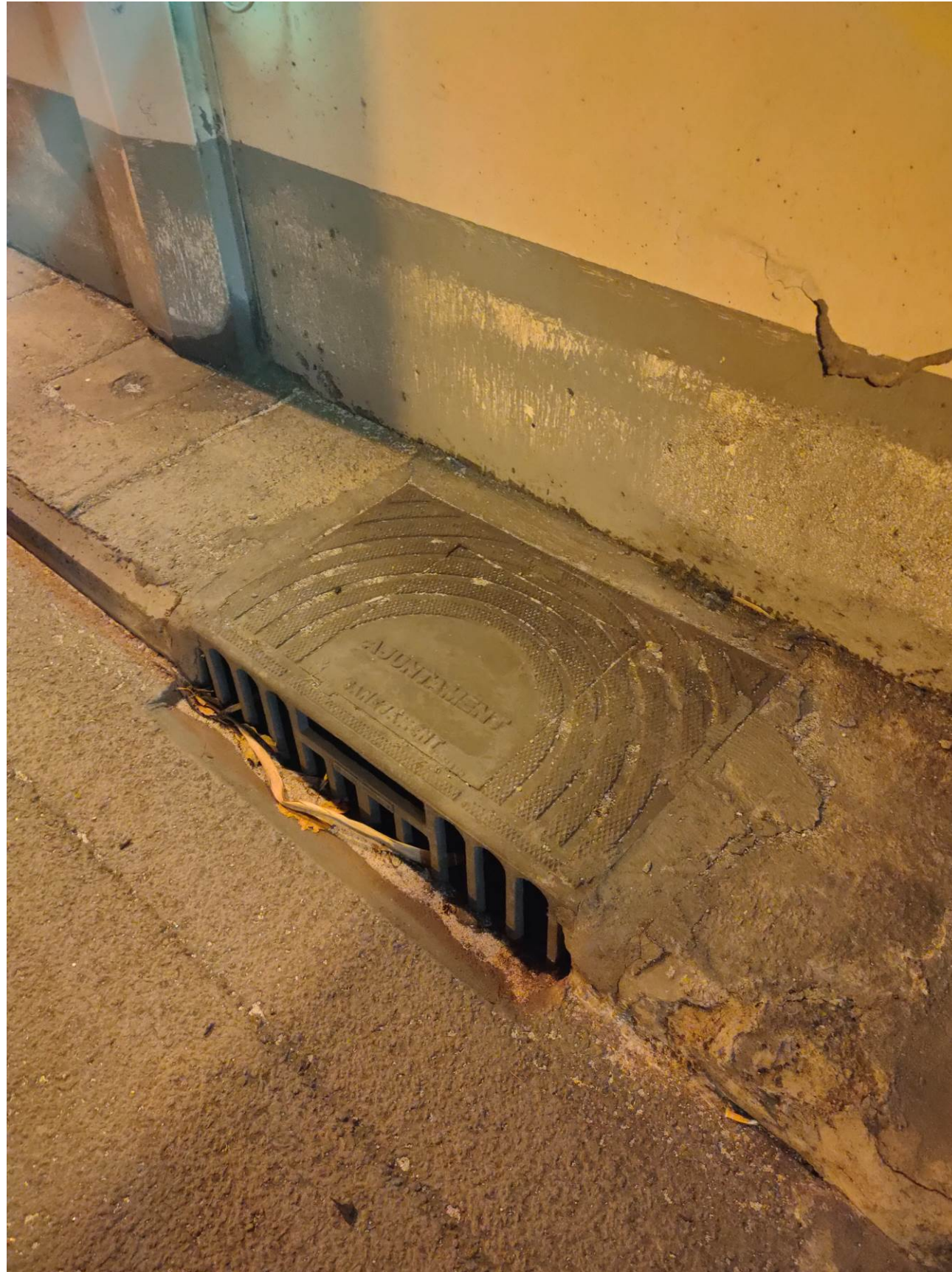
Imatge 3. Detall de tapa de clavegueram al voral de la B-10.
