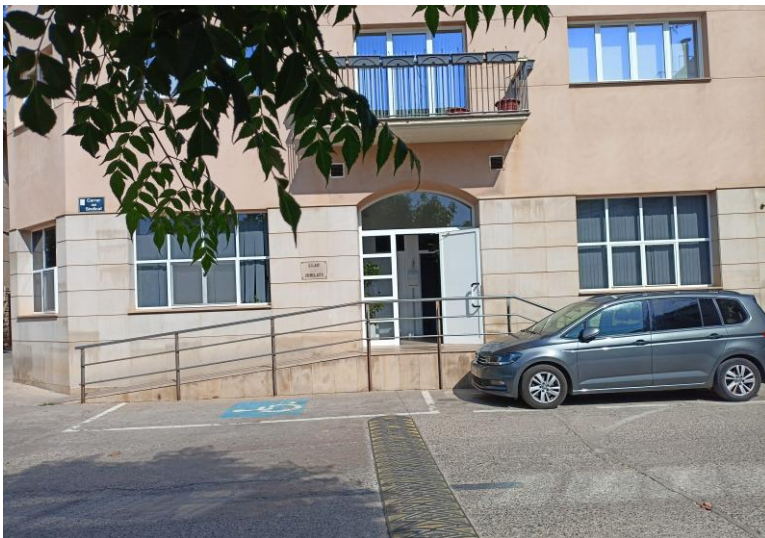
EDIFICI DE L'AJUNTAMENT OBJECTE DE REFORMA EN PB (ACCÉS C/SINDICAT)
