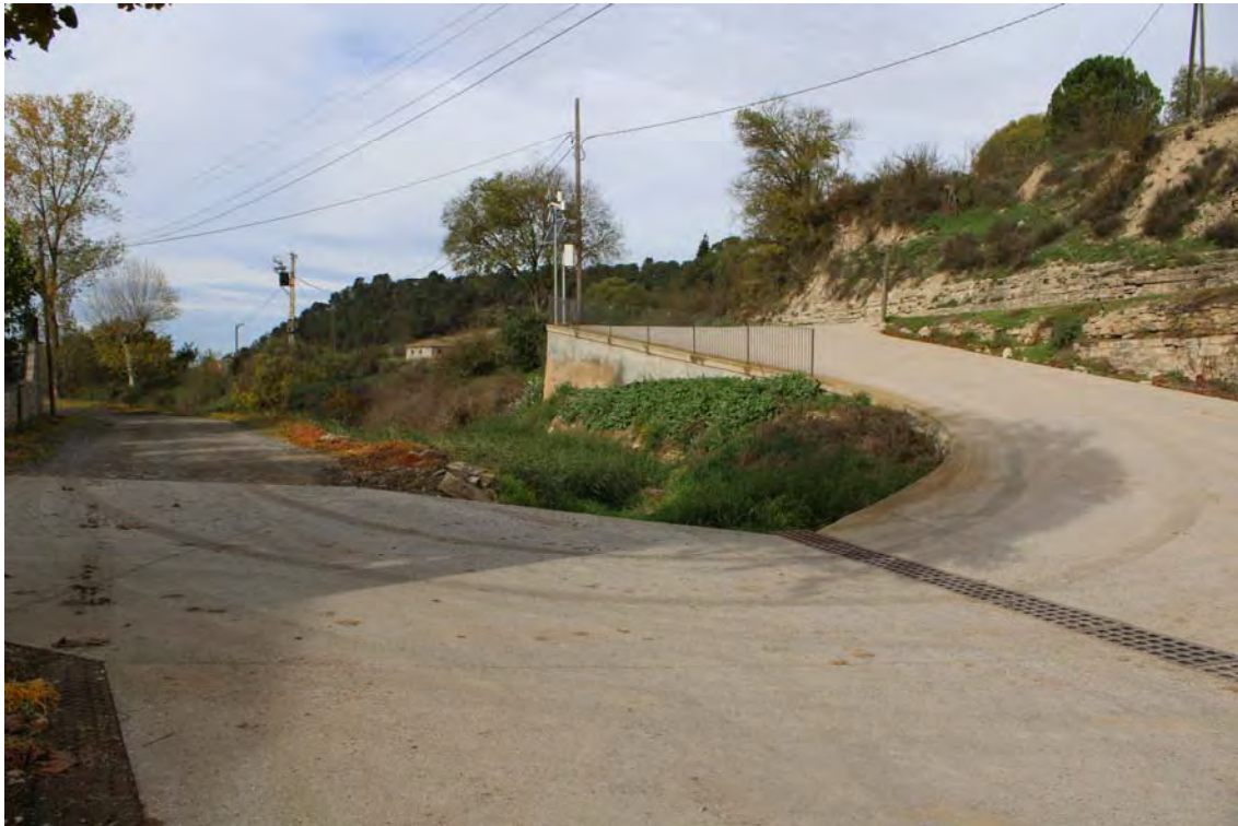
Encreuament del camí de Gàver amb la carretera de Sant Ramon, des d'on arriba la via alternativa de Sant Domí
