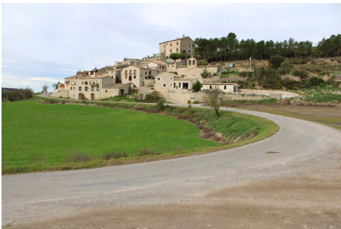
Arribada de la ruta a Estaràs des de la carretera de Sant Ramon
