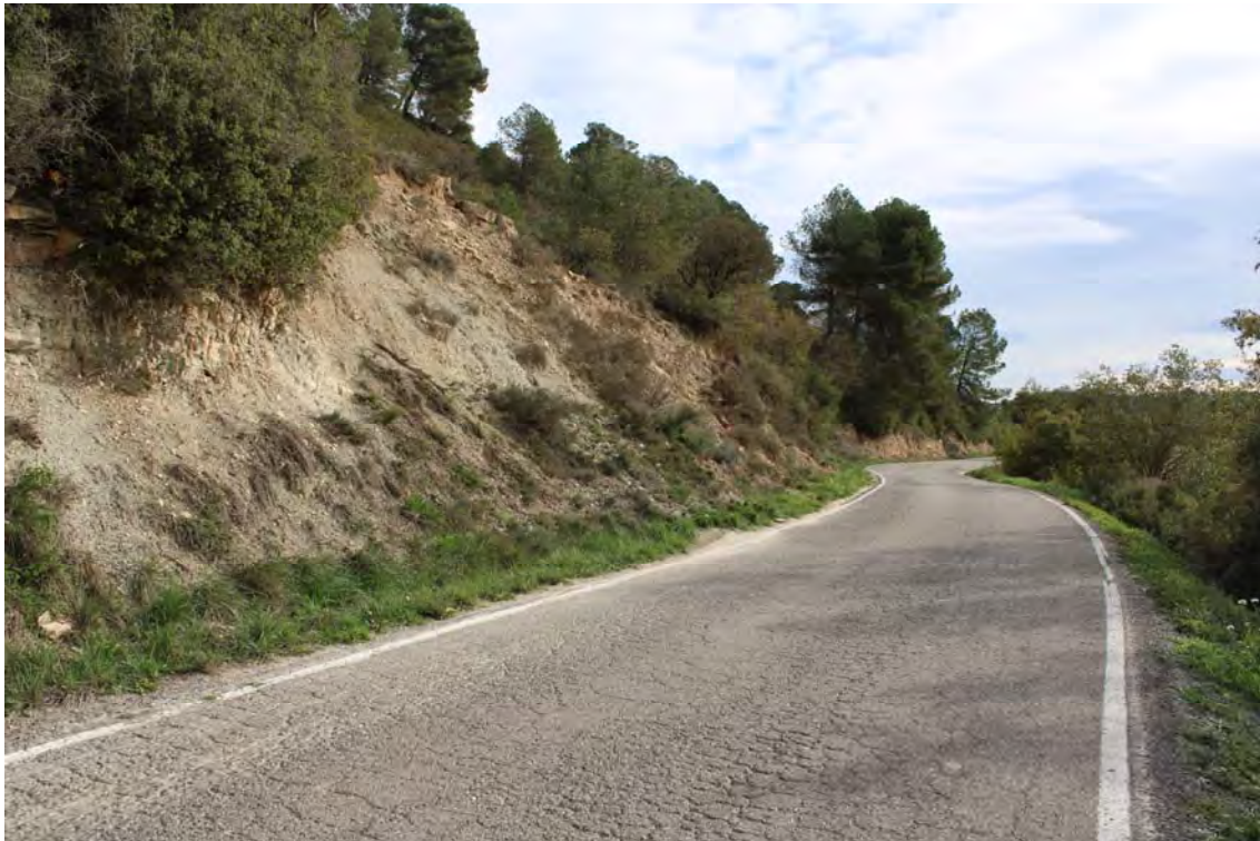
Exemple d'un dels punts del camí veïnal d'Estaràs on serà necessari retallar talussos per millorar la visibilitat i restaurar les cunetes
