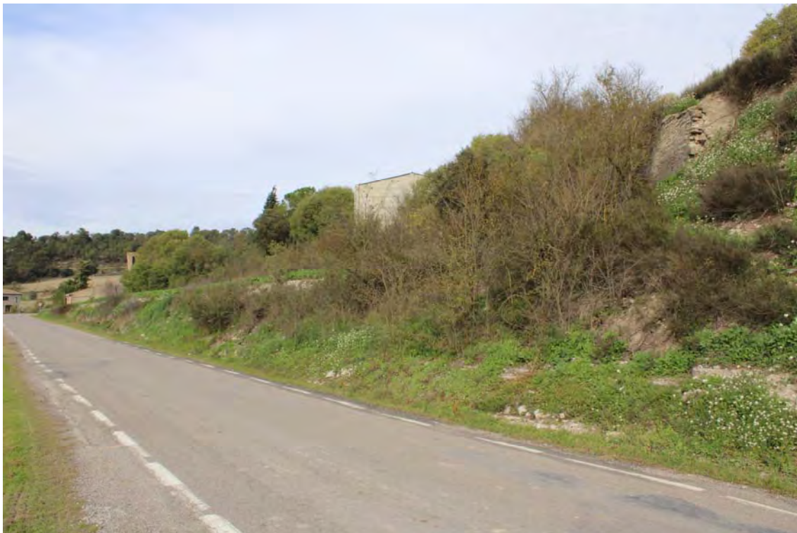
Punt de la carretera de Sant Ramon entre Gàver i Estaràs on es restaurarà un tram de cuneta
