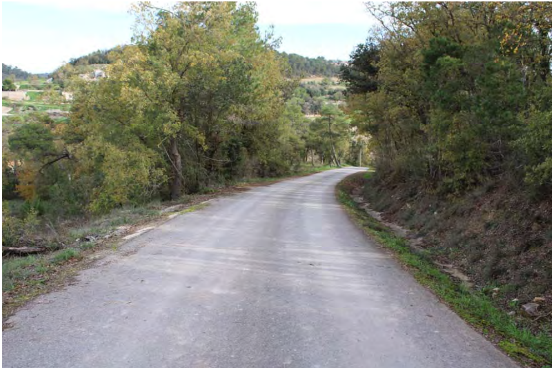
Punt del camí de Gàver on es restaurarà un tram de cuneta
