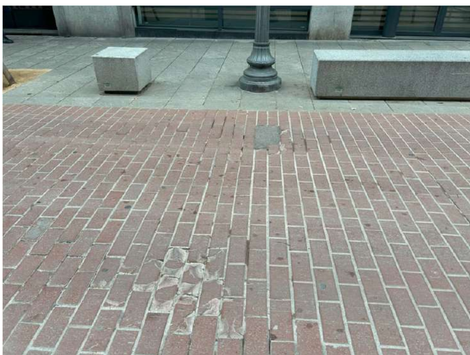
6. Trencament peces ceràmiques
