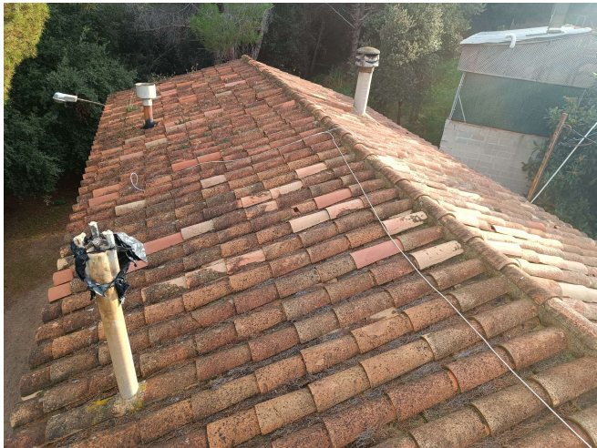
IMATGES DELS ELEMENTS DE FIBROCIMENT. De dreta a esquerre: porxo / xunts i xemeneies antigues / dipòsit d'aigua al sotacoberta
