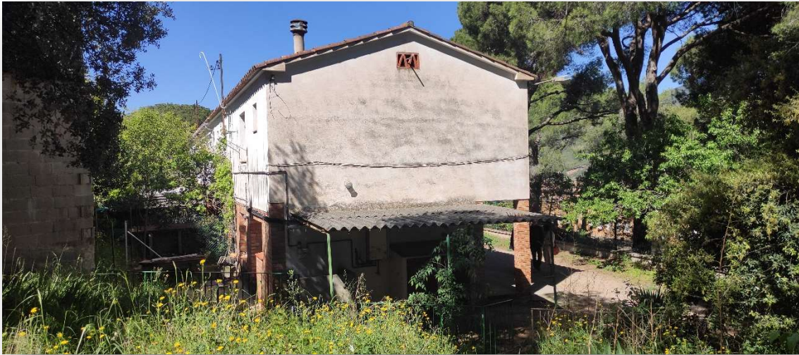
Imatge de la façana est on es troba el porxo de fibrociment.
