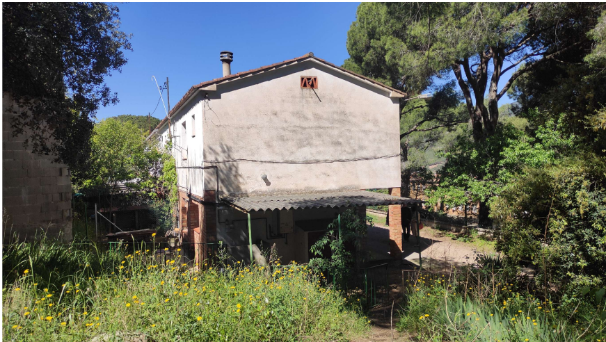
IMATGES DELS ELEMENTS DE FIBROCIMENT. De dreta a esquerre: porxo / xunts i xemeneies antigues / dipòsit d'aigua al sotacoberta
