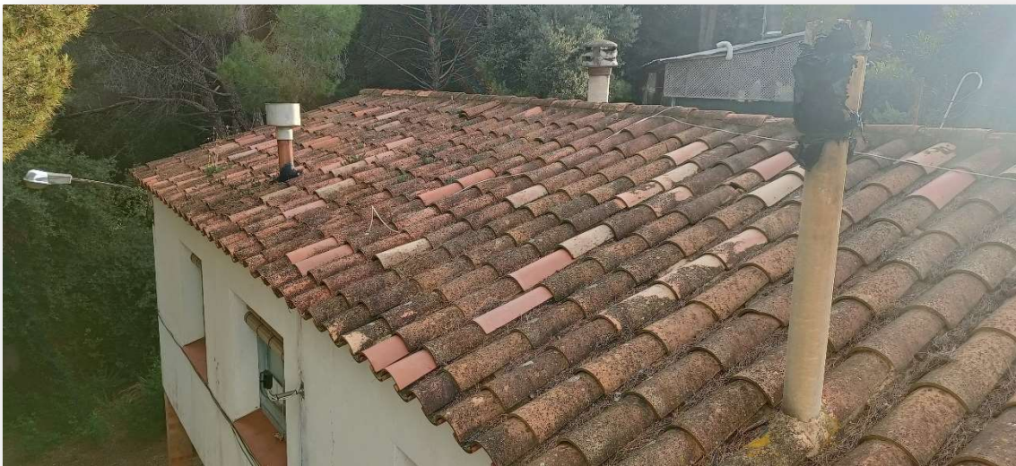
Imatge de la coberta amb elements de sortida de fums de fibrociment.
