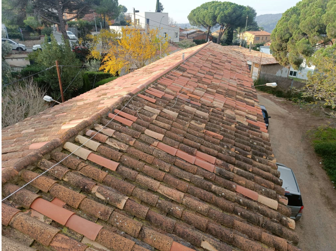
IMATGES DE LA COBERTA. A la segona imatge es veu la diferència entre la zona ja rehabilitada i la que no.
