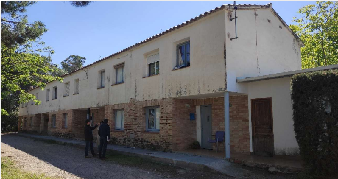
Imatge de la façana nord de l'edifici des d'on s'accedeix als 6 habitatges
