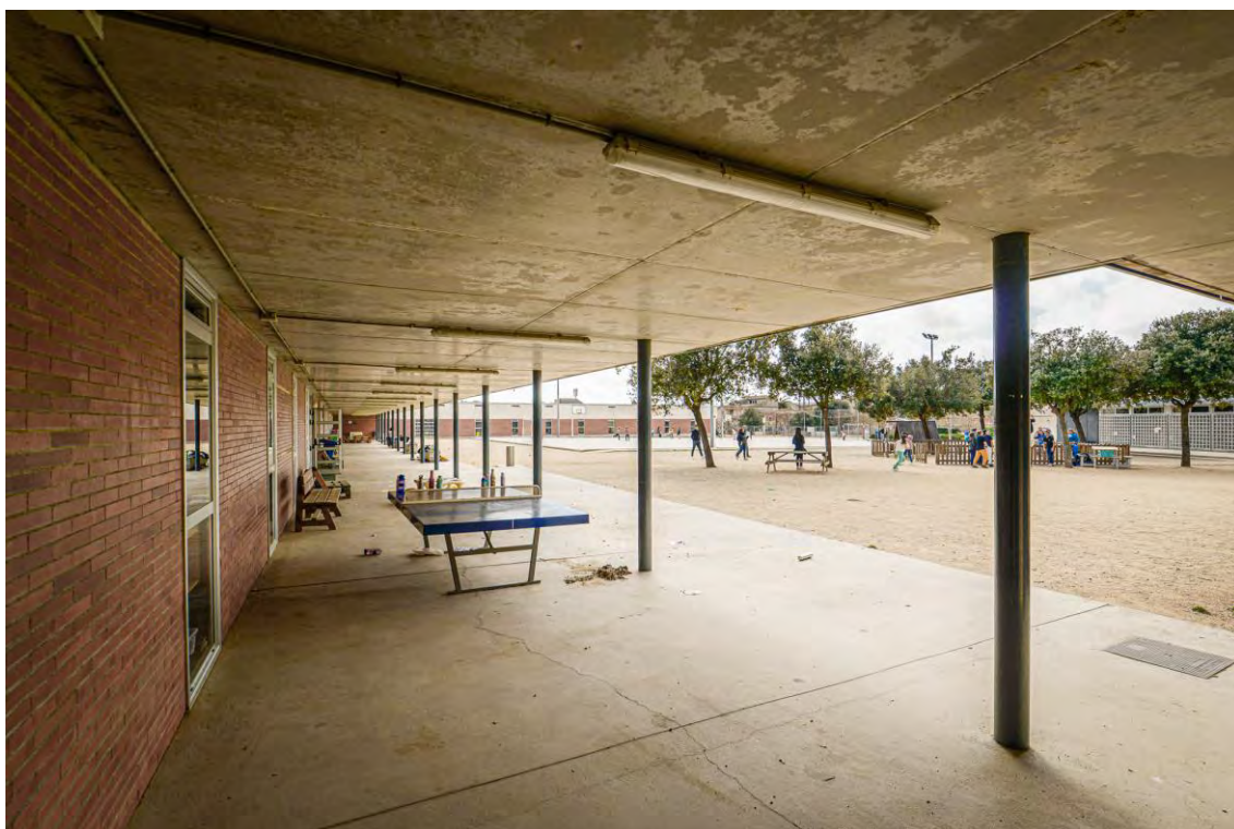
Fig. Vista del porxo. Font: elaboració pròpia.
