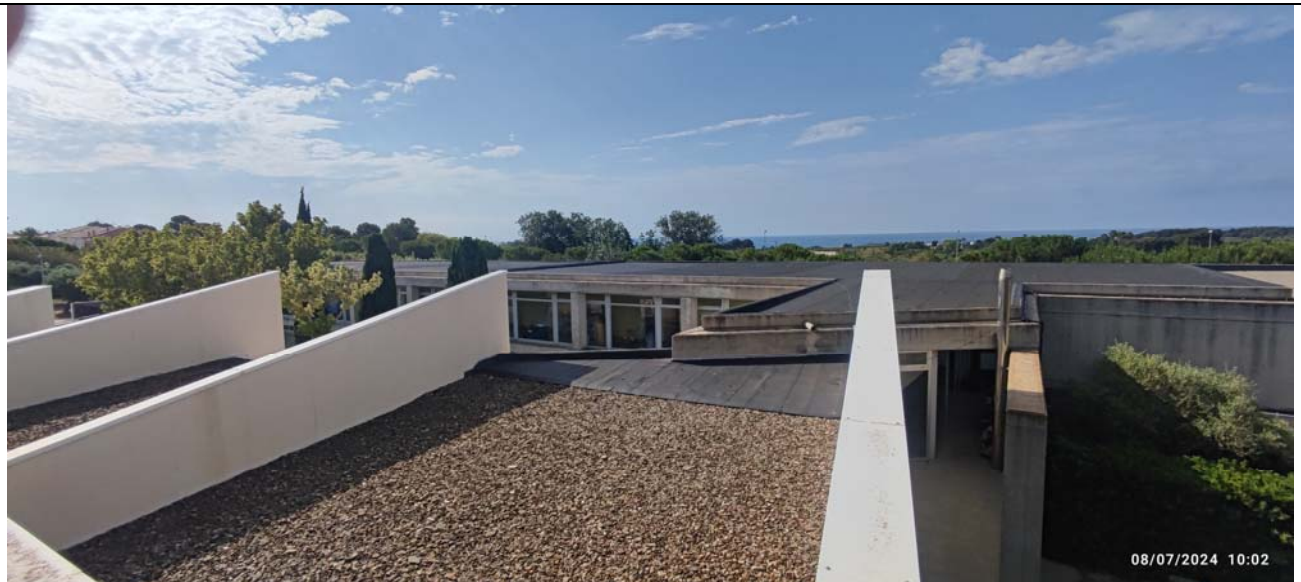
Coberta de la Portalada. Vista de les cobertes que no s'utilitzaran en aquest projecte
