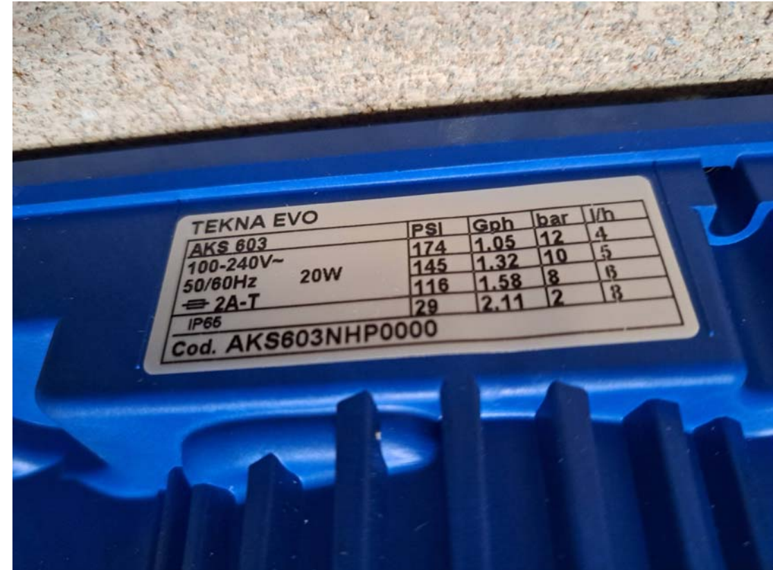
15. Placa de la bomba d'hipoclorit
