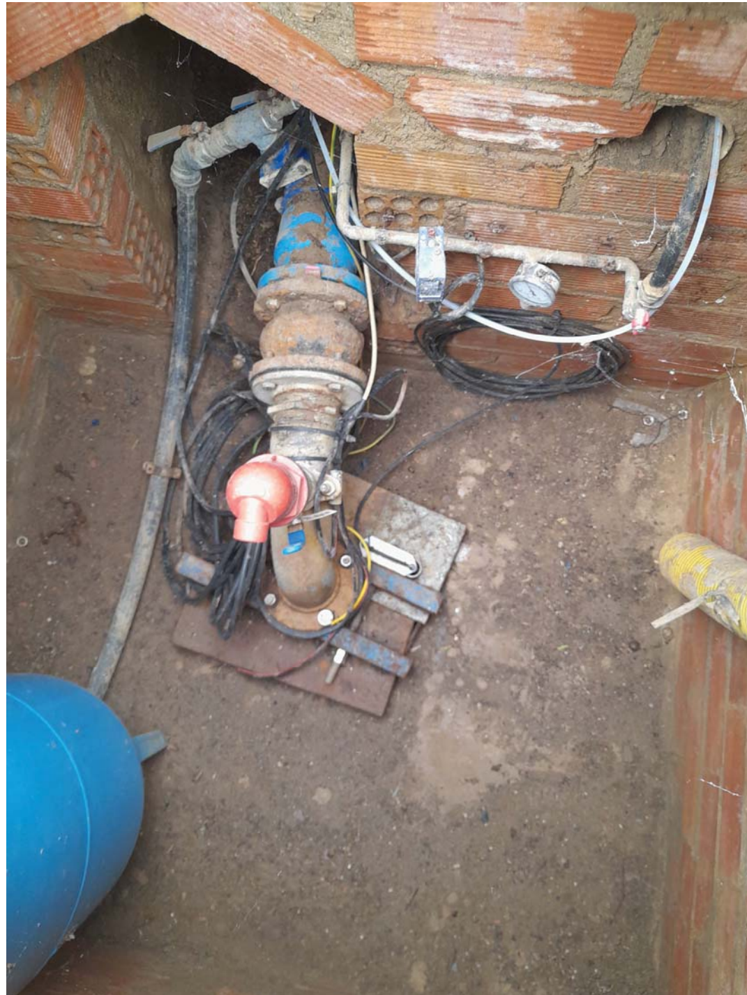
El pou ve traient entre 21 m3/h amb funcionament amb el temps força llargs.
