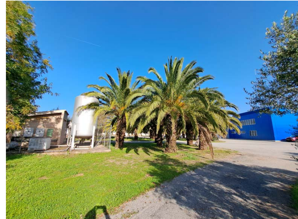
3. Zona posterior de la filtració existent
