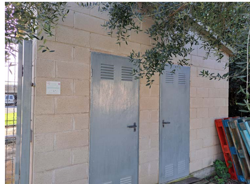
12. Caseta de cloració existent
