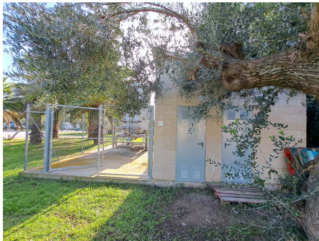
6. Caseta de cloració actual
