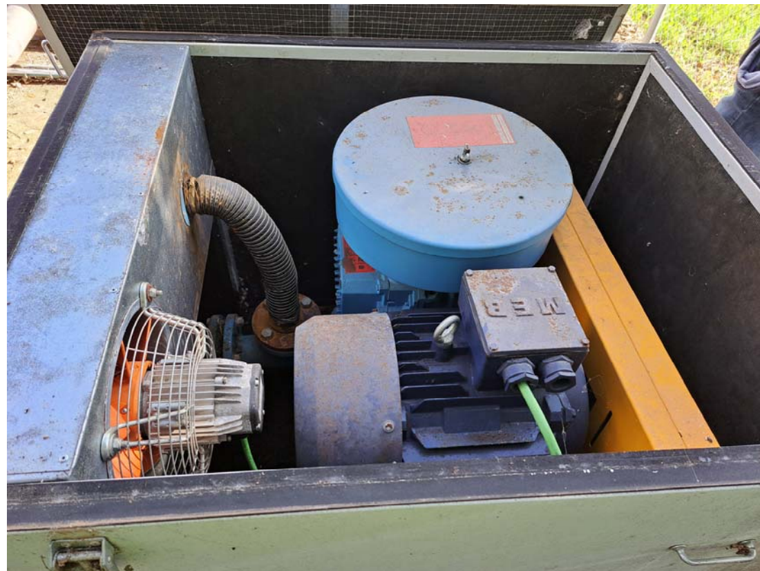
10. Bufant per a aire de rentat del filtre de carbó
