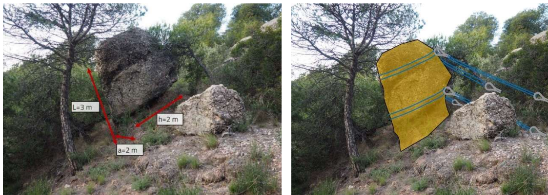
Fig. 27. Bloc inestable a mig vessant al sector A (esquerra) i actuació directa AD1 il·lustrativa amb malla de cable i ancoratges (dreta).
