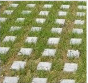
CORDÓ APARCAMENT (PAVIMENT DRENANT PECES DE FORMIGÓ)
