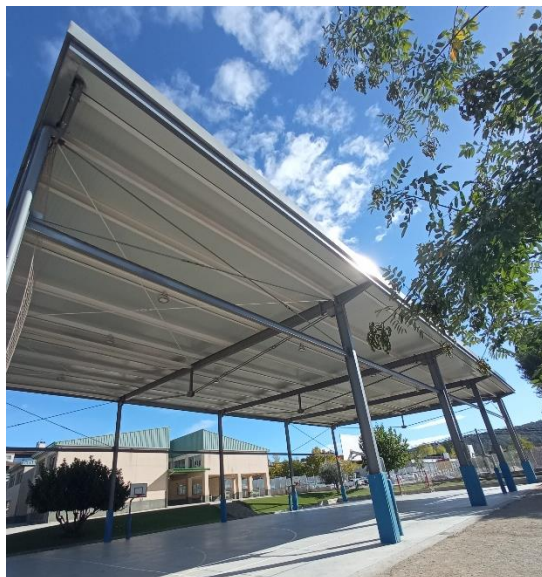
Figura 4. Coberta on s'instal·laran les plaques fotovoltaiques
