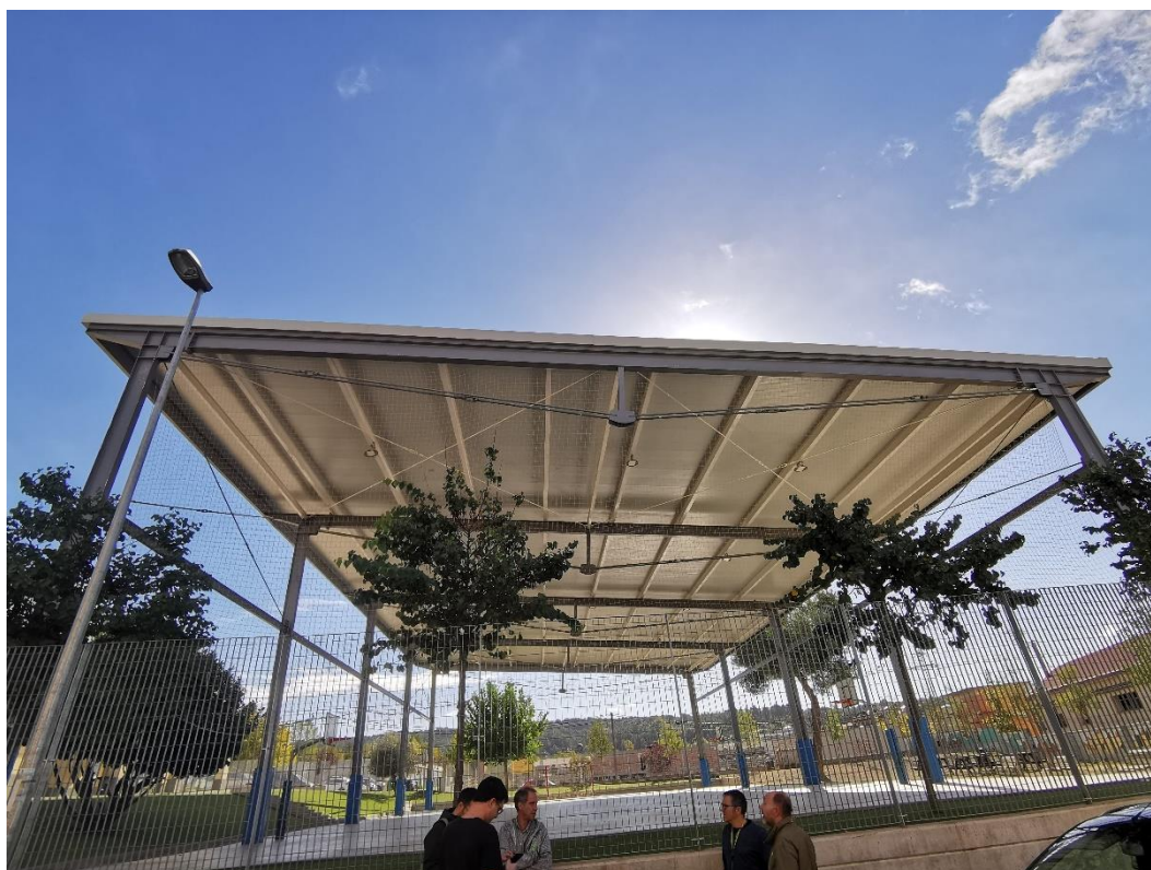
Figura 1. Vista exterior coberta 1
