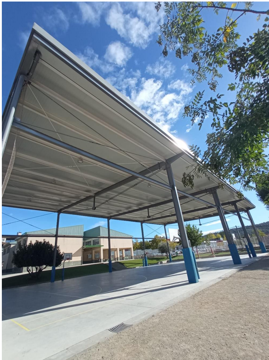
Figura 14. Estructura de la coberta.
