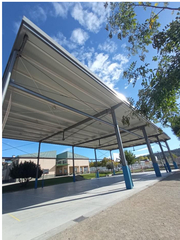
Figura 2. Vista exterior coberta 2
