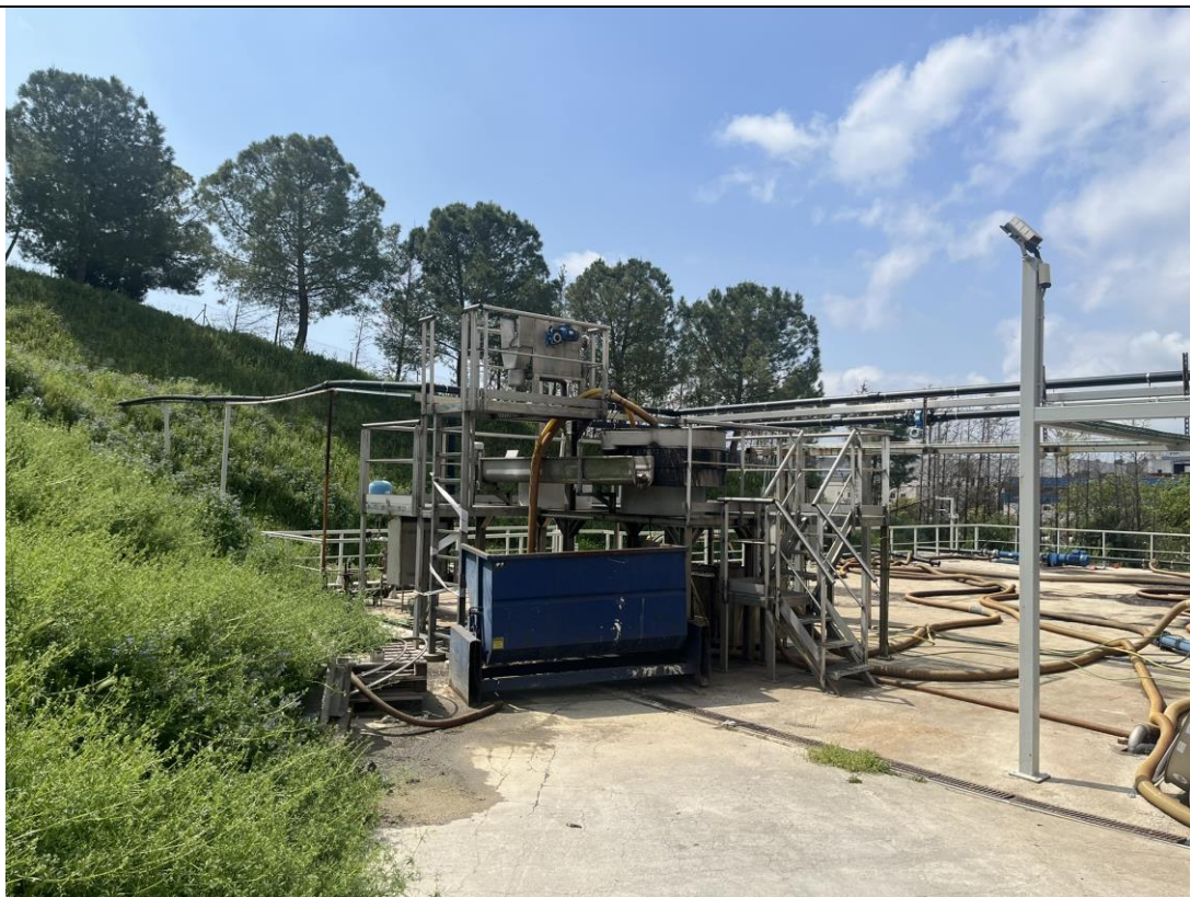
Tractament aigües, desbast inicial
