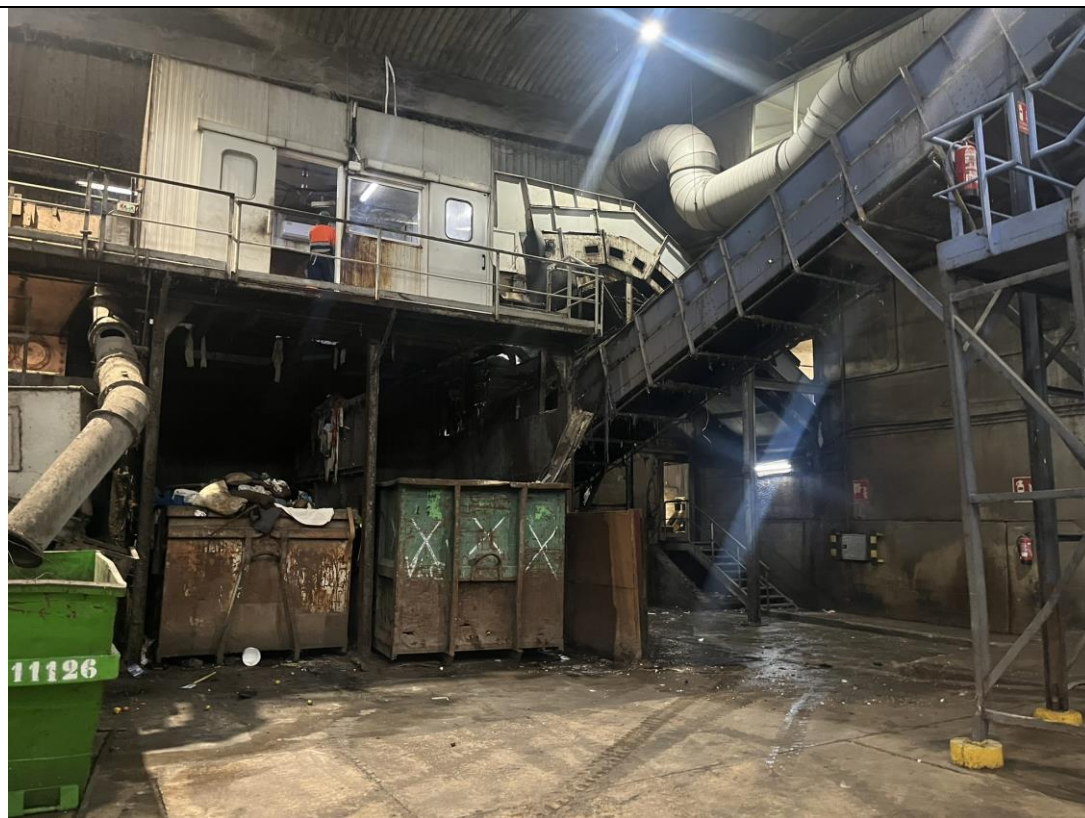
Cabina de triatge manual existent.
