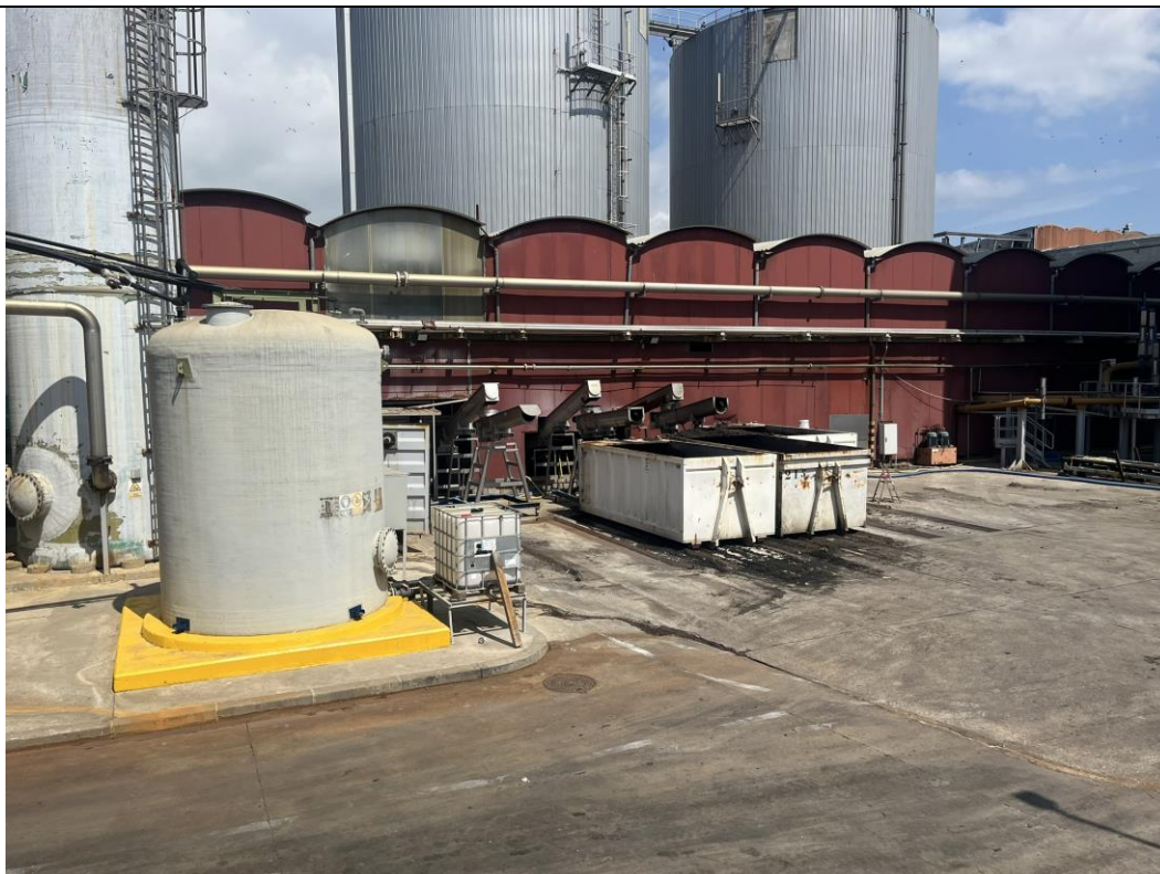
Vista exterior zona metanització.
