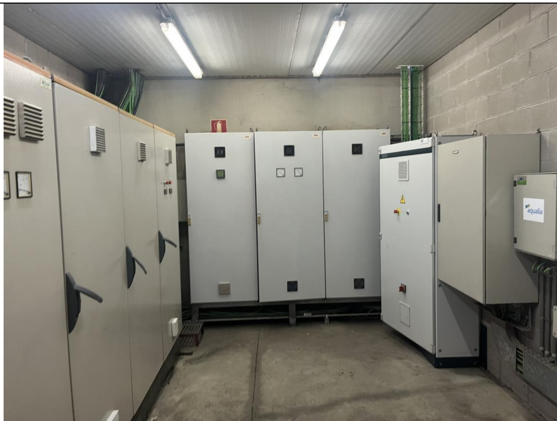
CCM tractament d'aigües
