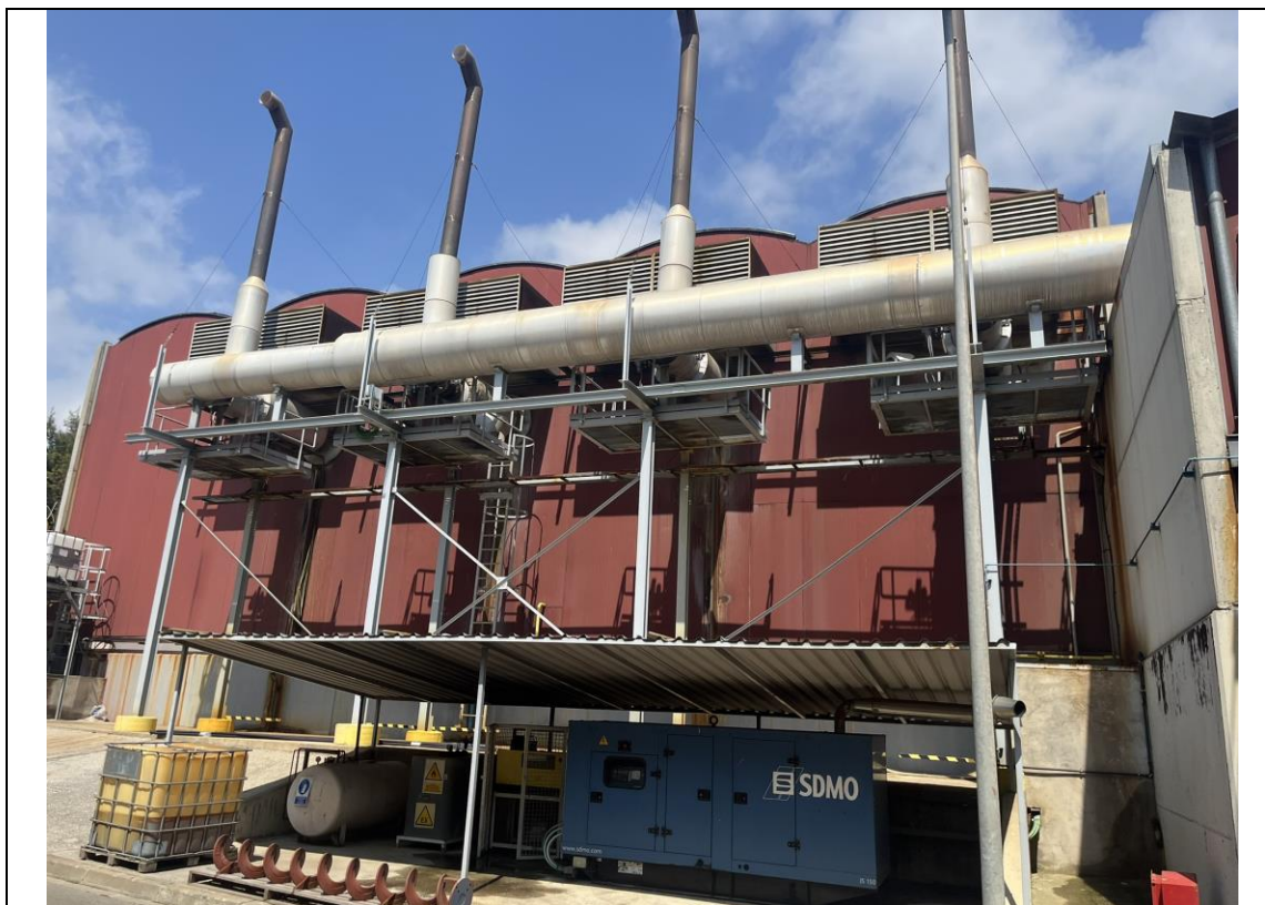
Vista exterior edifici cogeneració
