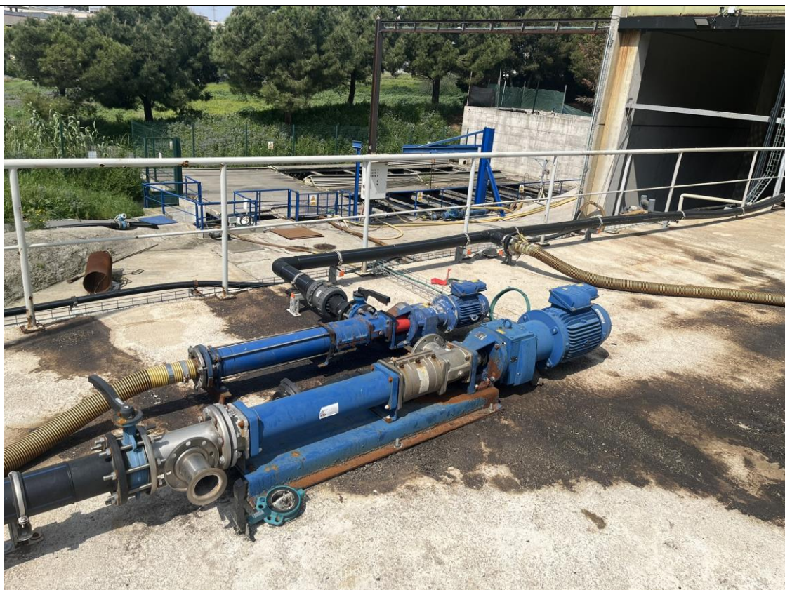
Tractament d'aigües, Bombes alimentació
