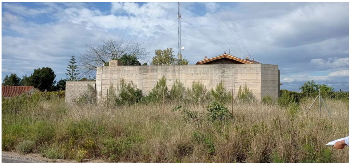
Imatge del dipòsit d'emmagatzematge de l'aigua per a la posterior distribució a La Cativera (Foto: maig de 2025)
