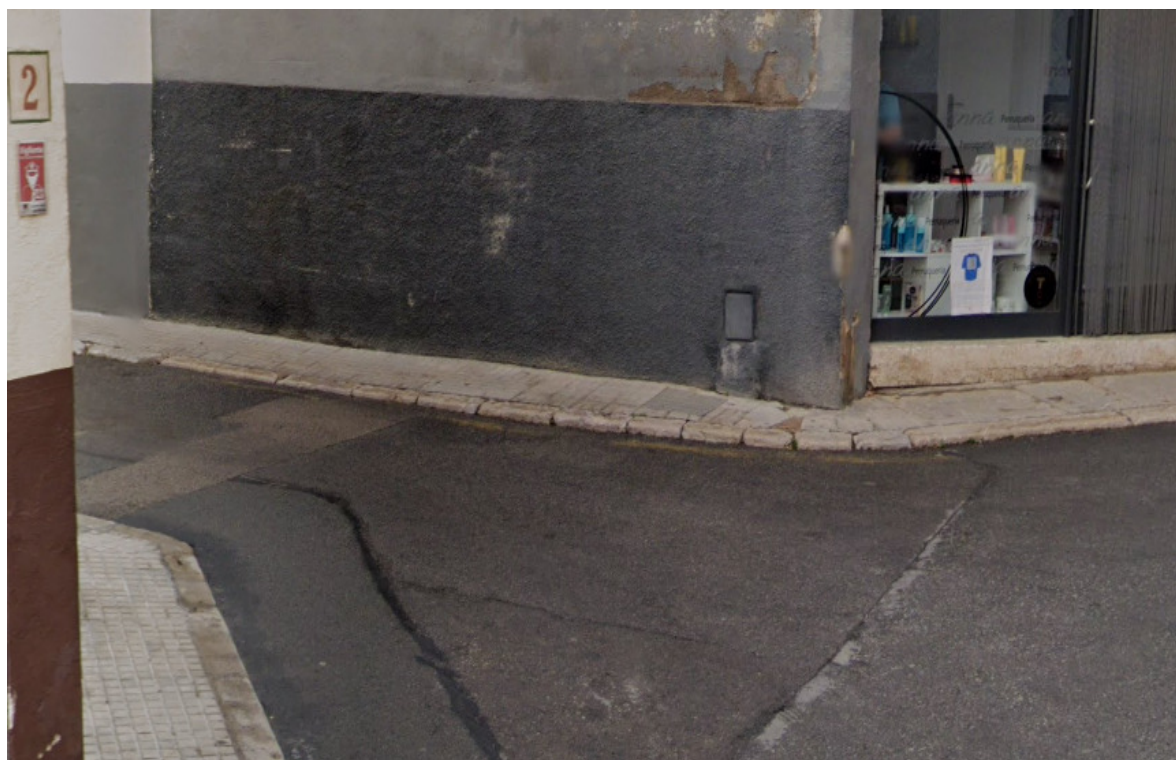
Foto 6 Ubicació vàlvula del Sector C-5. Casc antic Zona 2
