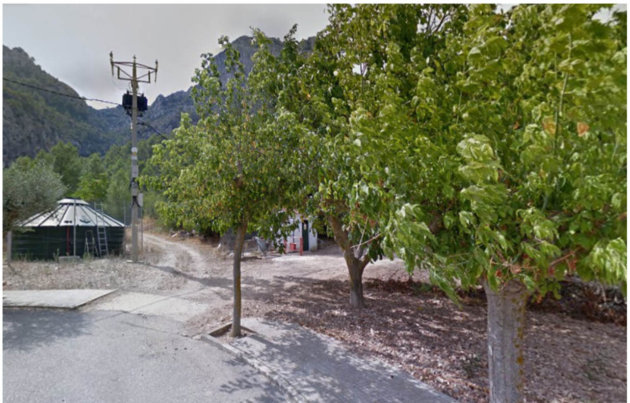
Foto 2. Ubicació vàlvula del Sector C-1. Tram sota dipòsit costat dret
