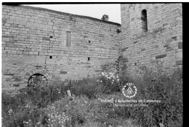
La junta entre campanar i façana S de l'església ja tapiada i la gàrgola en posició superior, arran de la restauració de 1959-1960 (Foto: Alejandro Ferrant, COAC Lleida)
