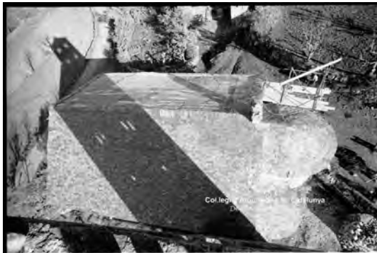
Pala del costat de l'Evangeli a mig desmuntar el llosat. Resten a lloc (no es varen enretirar?) les lloses dels marges de pala i part del llosat veí de l'ex:SPAdanya. Una lona cobreix una zona on ja s'hauria desmuntat l'empostissat?
