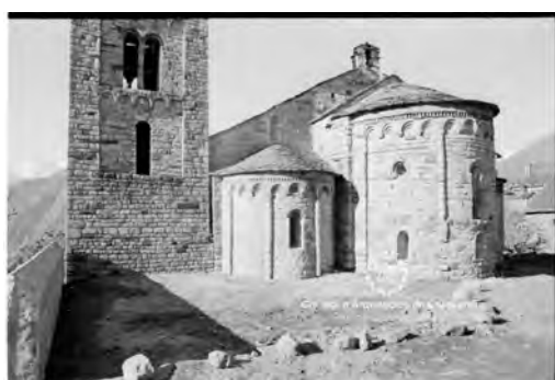
Imatges de la capçalera a mig restaurar, amb la finestra de la nau de l'epístola ja destapiada però sense coronament i imatge amb la finestra ja reconstruïda (Foto: Alejandro Ferrant. 1959-1960. COAC Lleida)
