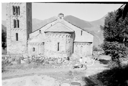
Imatges de la capçalera a mig restaurar, amb la finestra de la nau de l'epístola ja destapiada però sense coronament i imatge amb la finestra ja reconstruïda (Foto: Alejandro Ferrant. 1959-1960. COAC Lleida)
