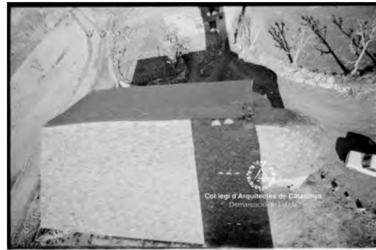
Pala del costat de l'Evangeli amb el llosat refet. Aquest és el llosat que ha arribat fins als nostres dies
