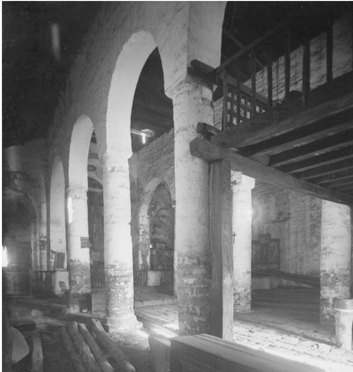
En primer pla, les posts i travessers que suporten l'estructura del cor fetes, versemblantment, amb bigues reaprofitades d'una coberta anterior (Foto: Arxiu Mas. 1907)
