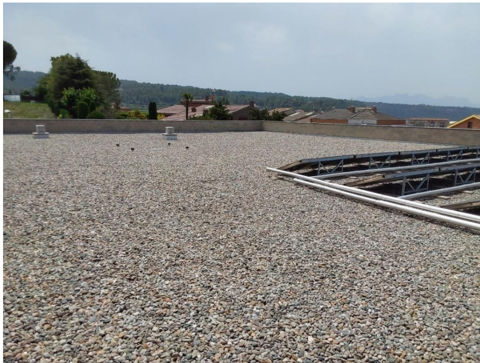
Planta coberta. Vista 1: orientació Sud
