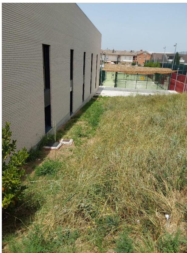
Façana de l'edifici i pas de canalitzacions per les EdRSR
