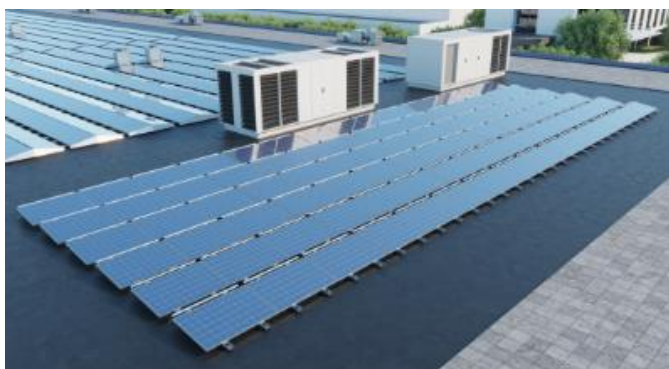
Estructura autoportant amb orientació Sud
