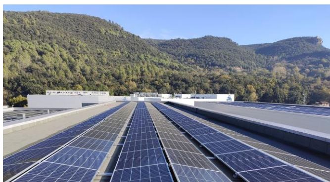
Estructura autoportant amb orientació Est-Oest
