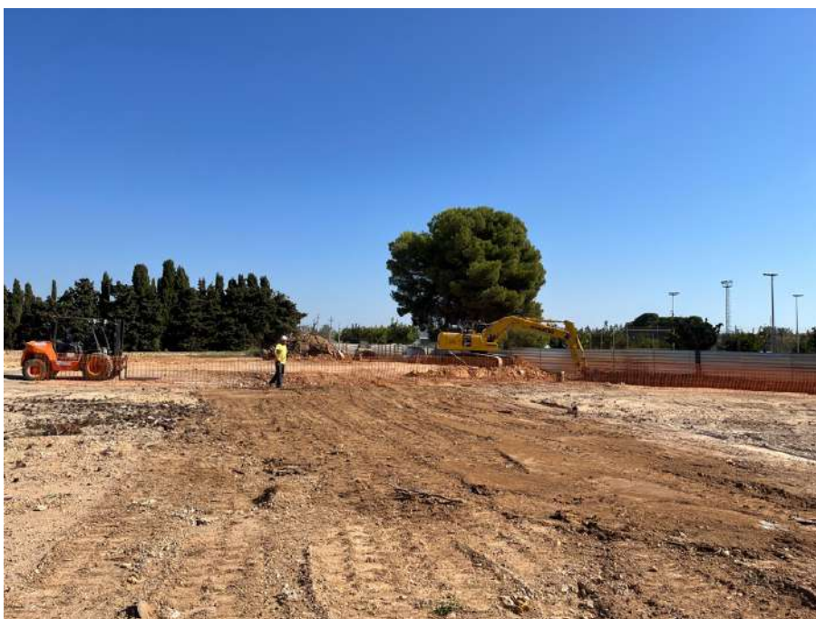
VISTA DES DEL CAMP FUTBOL PRINCIPAL CAP A L'EDIFICI GESTOR
