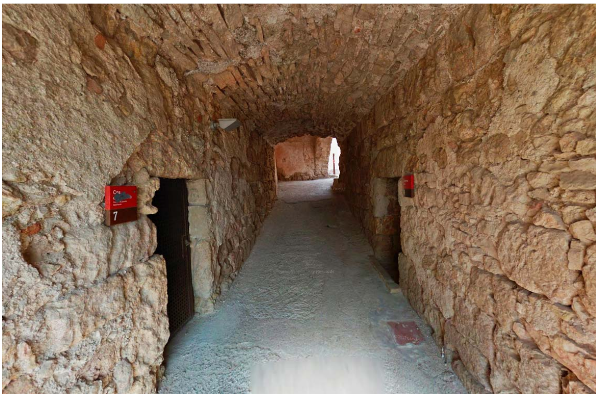
Fotografia 03. Aspecte del corredor en fotografia d'arxiu abans de la col·locació de la xarxa de protecció de la seva volta.
