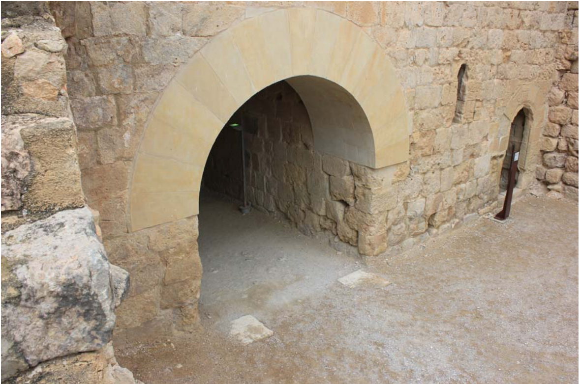
Fotografia 08. Detall de l'obertura en planta baixa del cos nord que a través d'un passadís condueix al celler.
