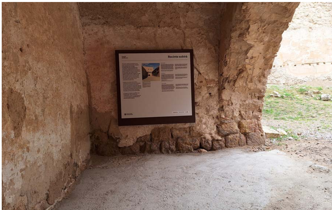
Fotografia 04. Detall de l'arrencament de l'arc de l'obertura lateral del segon tram que s'aboca cap a l'interior del pati d'armes.
