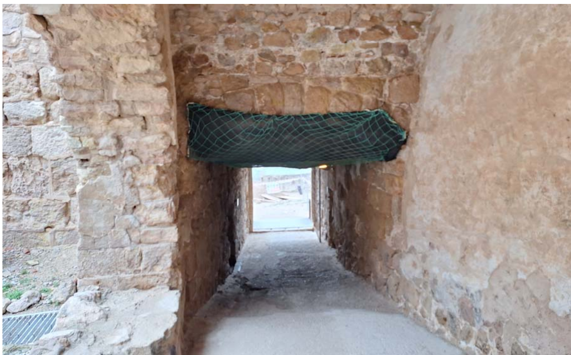
Fotografia 05. Imatge actual del corredor amb la xarxa de protecció instal·lada a la volta del seu primer tram.
