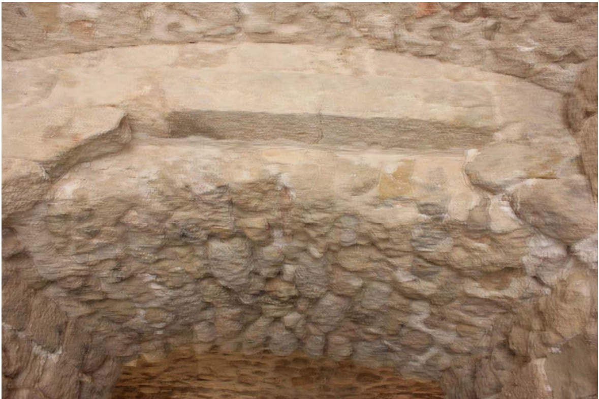
Fotografia 15. Emprems de la mateixa porta en la seva trobada amb el sostre del passadís.
