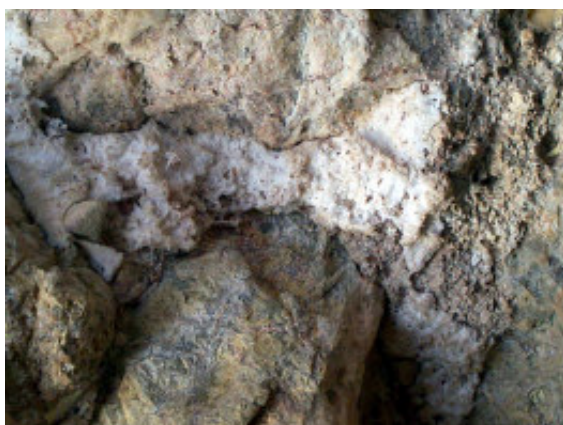
El creixement de sulfats de magnesi associat als morters és força evident.
