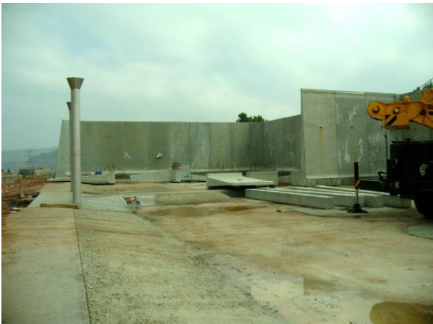
Vista de l'interior del dipòsit (fase obres de construcció) objecte de l'actuació.
