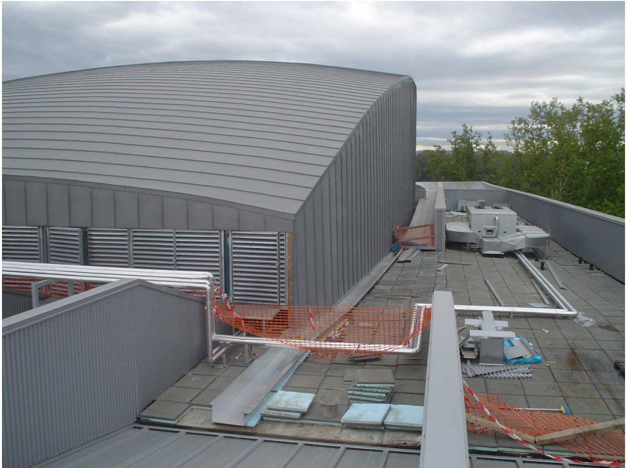
Imatge de la coberta de la zona amb paca "Filtron"
