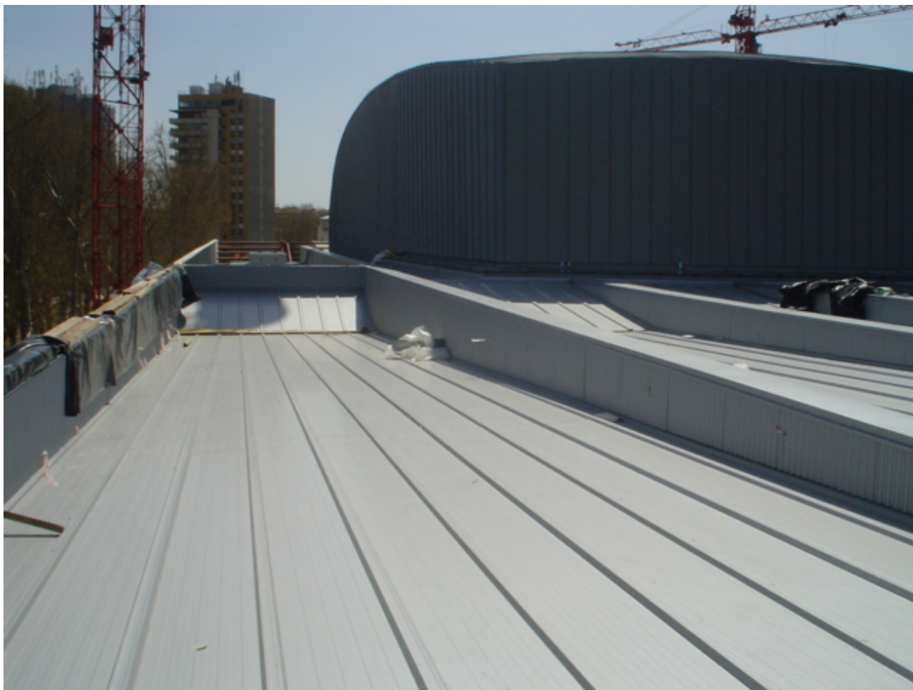
Imatge de la coberta de la zona 2
