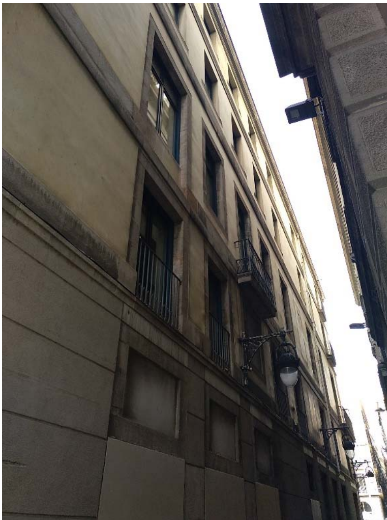
Façana C/ Boltres
