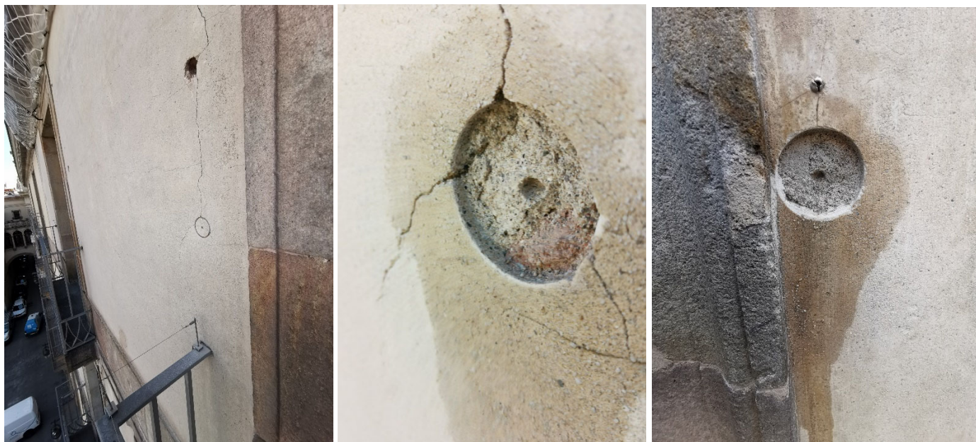
Cates extretes de diferents punts del parament: En totes es denota la bona qualitat de l'estuc i adherència amb l'arrebossat de base.
