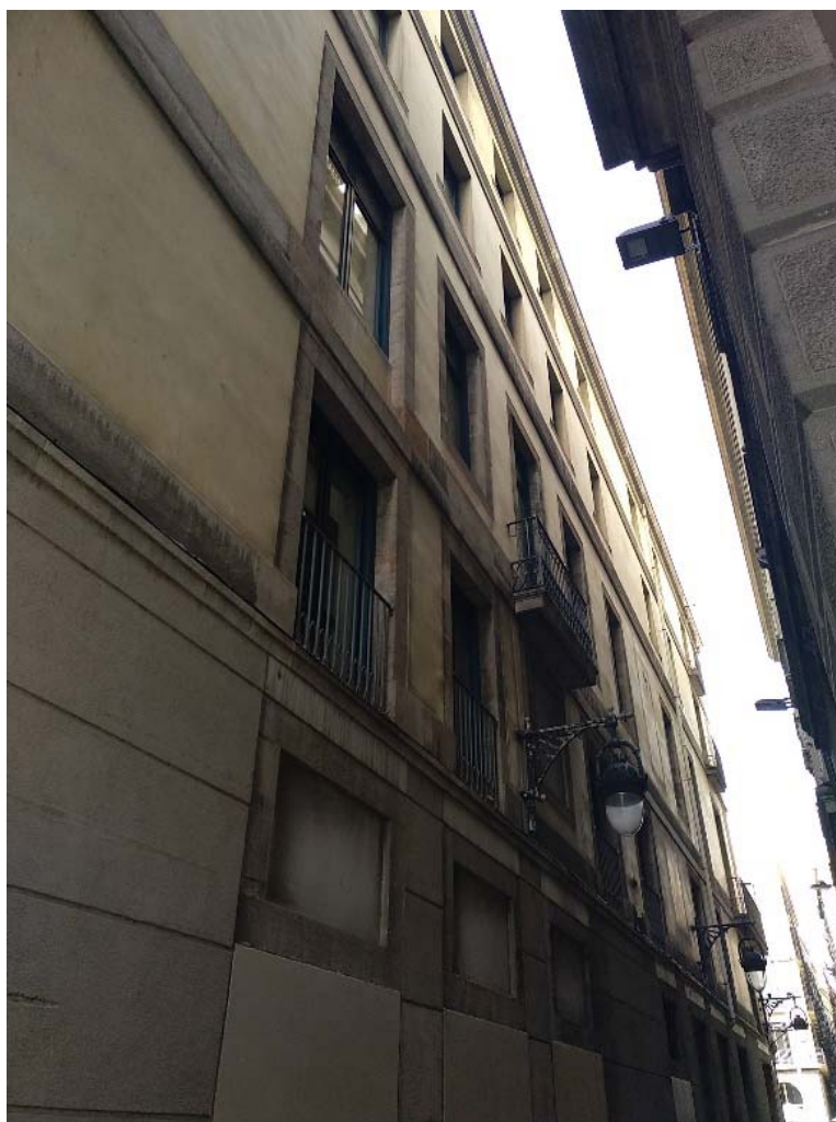
Façana C/ Boltres
