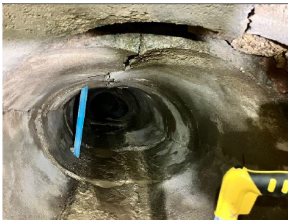
Detall del col·lector aixafat i esquerdat. L'atravessa un piezòmetre
