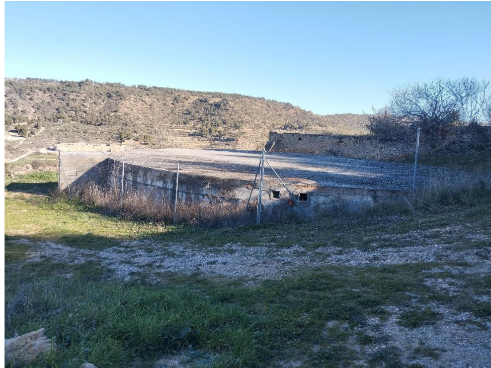
Figura 3. Vista exterior dipòsit Vell
