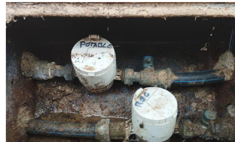
Figura 5: Escomesa doble amb els comptadors diferenciats del nucli urbà del municipi dels Torms
