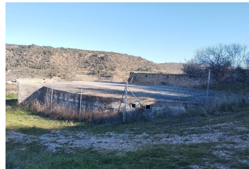
Figura 2: vista exterior dipòsit Vell
