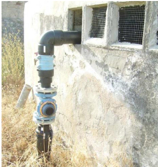
Figura 3: Entrada de la canonada de la Mancomunitat de Les Garrigues
