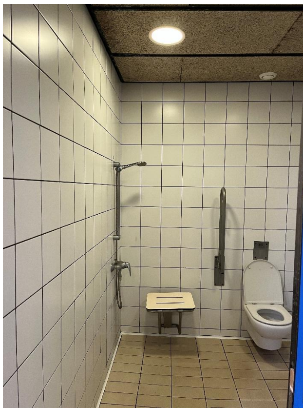
Bany adaptat vestidor abonats planta soterrani
