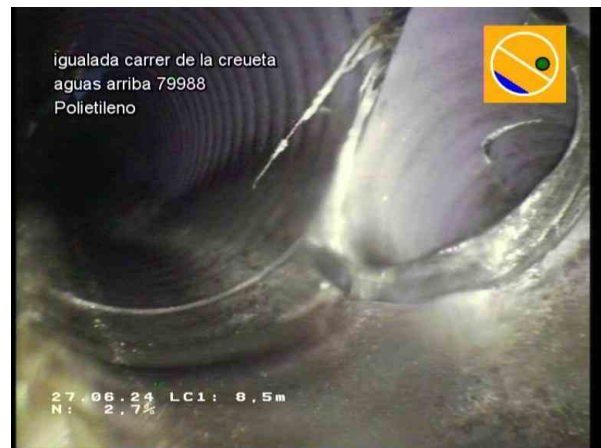
29763_2f9e282e-80a9-48c4-9a7e-58a68dfca97d_20240627_092219_527.jpg, 00:01:49, 8.50m Unión, conexión abierta., altura: 81mm, anchura: 81mm a 2 Reloj
