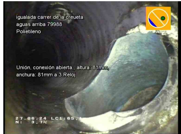
29763_a291754a-91ee-4dd7-8572-66a6b1f15a0a_20240627_093839_953.jpg, 00:14:26, 65.10m Unión, conexión abierta., altura: 81mm, anchura: 81mm a 3 Reloj
