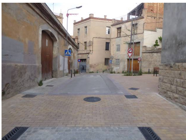
Vista general xamfrà C/Creueta amb carrer del Sol
