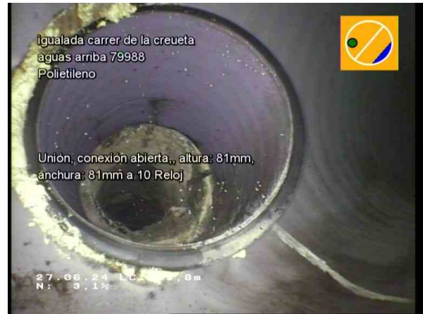
29763_e80d1b43-2f32-4d44-bf65-1de9109fc7ac_20240627_095313_543.jpg, 00:23:12, 89.80m Unión, conexión abierta., altura: 81mm, anchura: 81mm a 10 Reloj
