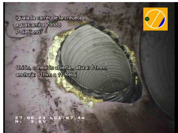
29763_4cf852a5-8a2c-47e1-81fb-11291e4f2055_20240627_095611_701.jpg, 00:25:46, 97.40m Unión, conexión abierta., altura: 81mm, anchura: 81mm a 11 Reloj
