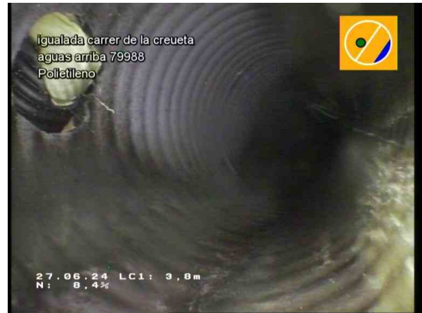
29763_2677fa08-7200-4891-b804-5959fce57007_20240627_092111_217.jpg, 00:00:49, 3.80m Unión, conexión abierta., altura: 81mm, anchura: 81mm a 11 Reloj
