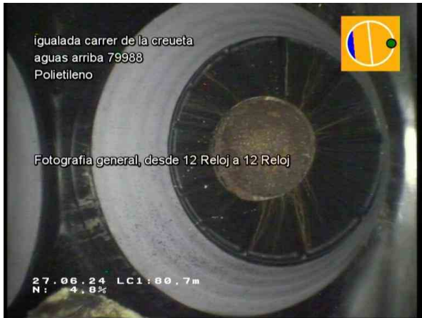
29763_ac38d66a-5271-48f8-94ce-d880eeacd9c6_20240627_094535_729.jpg, 00:20:06, 80.70m Fotografía general, desde 12 Reloj a 12 Reloj / poco oculto
