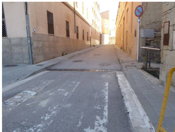
Vista general C/Creueta connexió amb Ronda del Rec
