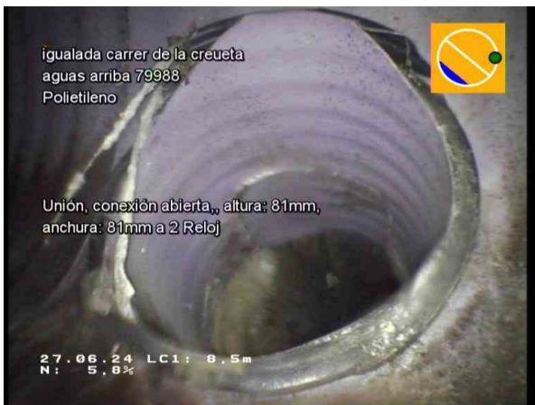
29763_c880a771-4674-4bbb-b4ba-5d37556fdea2_20240627_092210_690.jpg, 00:01:49, 8.50m Unión, conexión abierta., altura: 81mm, anchura: 81mm a 2 Reloj
