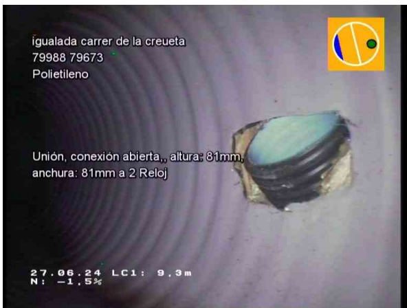
29764_4b2fde60-3e7e-4d98-a1a7-9285bfdeda2a_20240627_101919_688.jpg, 00:01:16, 9.30m Unión, conexión abierta,, altura: 81mm, anchura: 81mm a 2 Reloj
