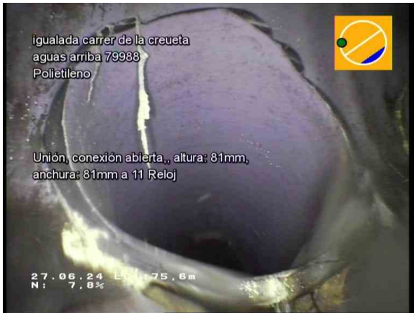
29763_346143a5-dfcd-4ac1-b7e1-9ba5e6baee3f_20240627_094227_432.jpg, 00:17:43, 75.60m Unión, conexión abierta., altura: 81mm, anchura: 81mm a 11 Reloj
