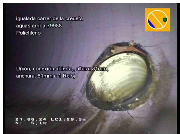
29763_dd56abcd-124f-48cd-b549-7db5bc1b3798_20240627_092746_022.jpg, 00:06:47, 29.50m Unión, conexión abierta., altura: 81mm, anchura: 81mm a 1 Reloj
