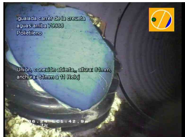
29763_e55e86b0-29a0-429d-87ce-4375aa5f6f3e_20240627_093223_046.jpg, 00:09:13, 42.90m Unión, conexión abierta., altura: 81mm, anchura: 81mm a 11 Reloj
