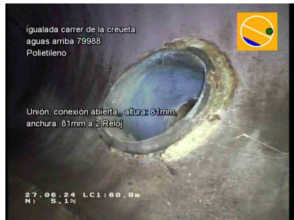
29763_7f0b9d76-cfba-4239-b3a0-9c654ce306e9_20240627_093648_140.jpg, 00:12:55, 60.00m Unión, conexión abierta., altura: 81mm, anchura: 81mm a 2 Reloj
