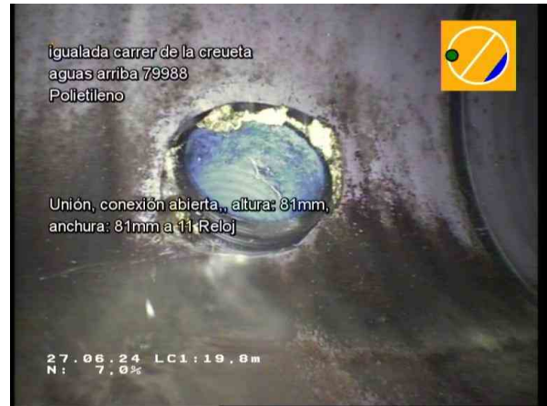
29763_3a3950a5-0404-41d3-a650-9c8a58294f6e_20240627_092515_109.jpg, 00:04:30, 19.80m Unión, conexión abierta., altura: 81mm, anchura: 81mm a 11 Reloj
