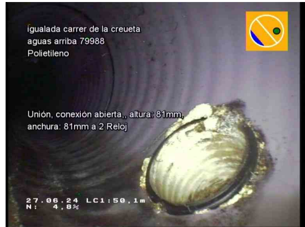
29763_9f1c08b6-6254-4efe-9c2c-e499334114fb_20240627_093418_424.jpg, 00:10:45, 50.10m Unión, conexión abierta., altura: 81mm, anchura: 81mm a 2 Reloj
