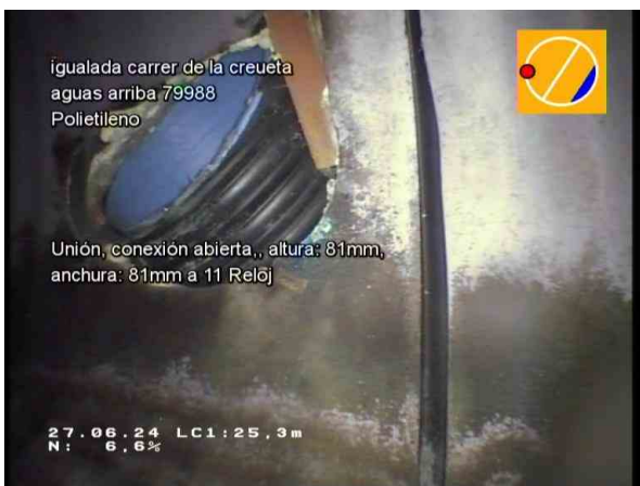
29763_600ca89c-c167-45b1-8e49-23ff3ec7086b_20240627_092644_976.jpg, 00:05:49, 25.30m Unión, conexión abierta., altura: 81mm, anchura: 81mm a 11 Reloj
