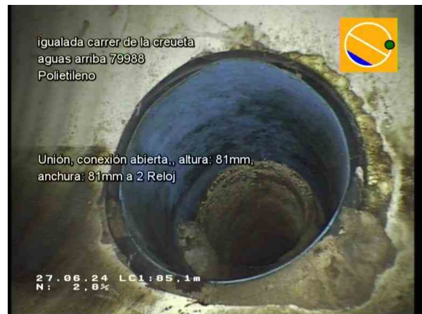
29763_b533d803-7357-459e-9295-f6551d33480c_20240627_095116_975.jpg, 00:21:38, 85.10m Unión, conexión abierta., altura: 81mm, anchura: 81mm a 2 Reloj
