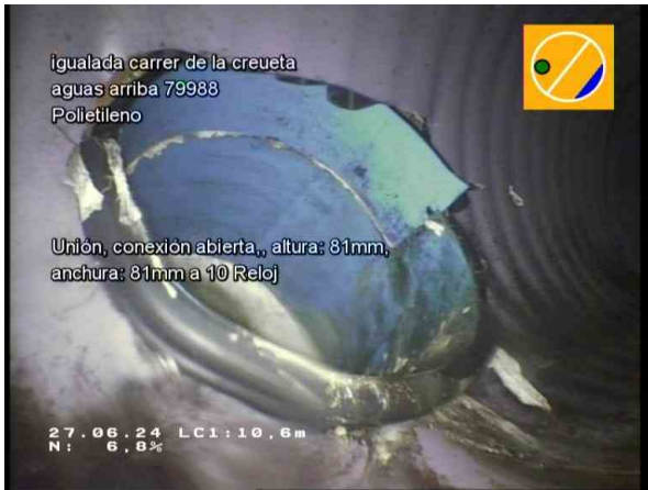
29763_a6153958-2154-4078-94ca-0b1aab71de0c_20240627_092316_831.jpg, 00:02:43, 10.60m Unión, conexión abierta., altura: 81mm, anchura: 81mm a 10 Reloj
