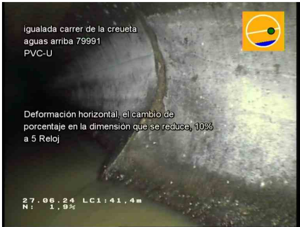
29765_7168afd5-ba00-4976-b989-1215baf87006_20240627_114618_432.jpg, 00:08:47, 41.40m Deformación horizontal, el cambio de porcentaje en la dimensión que se reduce, 10% a 5 Reloj
