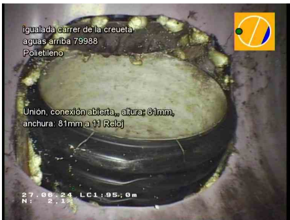
29763_ad6fd9d4-cf2a-4f1f-9cb4-aa9d415fd0c8_20240627_095520_583.jpg, 00:25:08, 95.00m Unión, conexión abierta., altura: 81mm, anchura: 81mm a 11 Reloj
