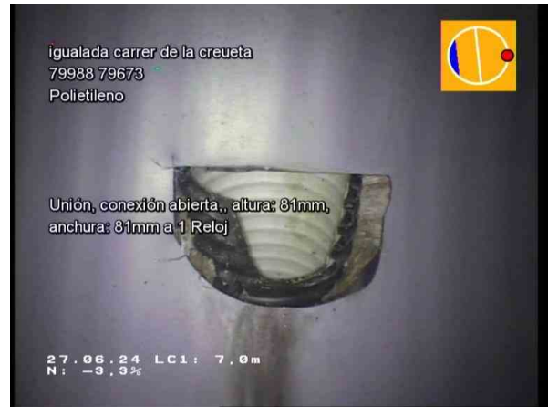
29764_a5397d2f-e6cc-43e3-827a-ad43387c0801_20240627_101858_399.jpg, 00:01:03, 7.00m Unión, conexión abierta,, altura: 81mm, anchura: 81mm a 1 Reloj
