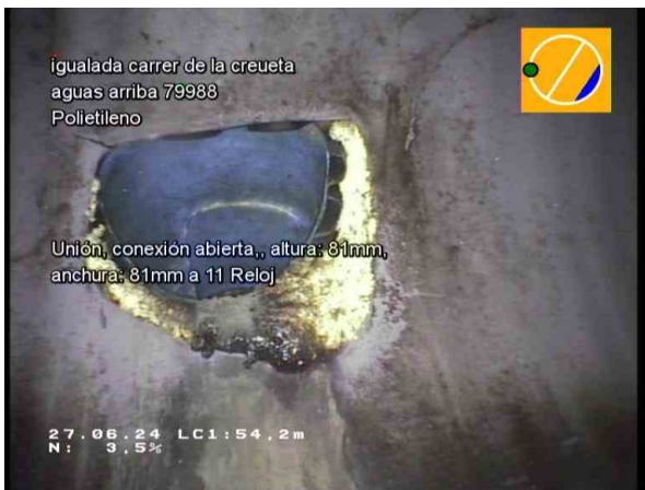
29763_7b568065-b107-4663-95b0-efa7308aeb9_20240627_093520_771.jpg, 00:11:39, 54.20m Unión, conexión abierta., altura: 81mm, anchura: 81mm a 11 Reloj
