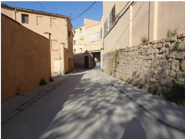
Vista general C/Creueta propera a la ronda del Rec
