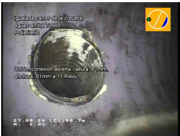
29763_5438b3ba-0344-4dc4-8f0a-f9dd973e1841_20240627_093924_104.jpg, 00:15:00, 66.70m Unión, conexión abierta., altura: 81mm, anchura: 81mm a 11 Reloj
