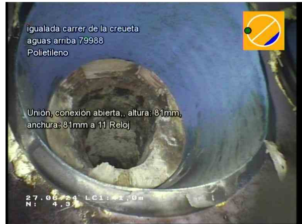
29763_67c7ab8d-8be6-4883-8814-fe1a51bccd0c_20240627_093124_440.jpg, 00:08:33, 41.00m Unión, conexión abierta., altura: 81mm, anchura: 81mm a 11 Reloj
