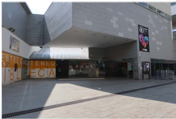
VISTA GENERAL EXTERIOR. TANCAMENT FRONTAL. ACCÉS
