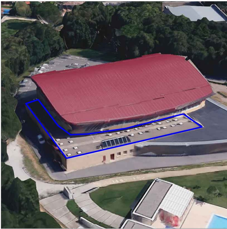
FIG 04. VISTA AÈRIA SUD
