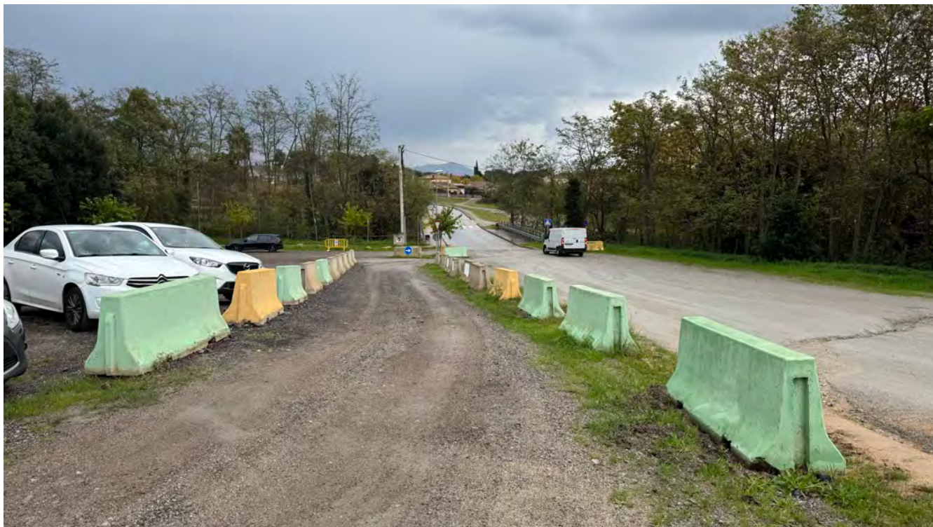
Perspectiva a continuació del tram de corba de la imatge anterior i fins la part final inferior de la zona d'aparcament. En segon terme es pot observar el pont que creua la Riera de Canyes.
