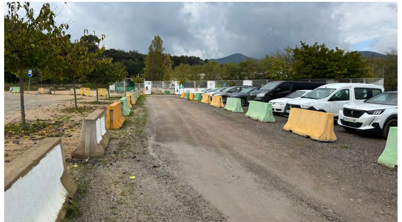
Perspectiva inversa, és a dir en sentit contrari al de la marxa dels vehicles que voregen la zona d'aparcament. El paviment de la zona de circulació és del mateix tipus que el de la zona d'aparcament de vehicles. Està format per materials granulars reciclats tipus formigó i fressat d'asfalt que amb el pas del temps s'ha acabat barrejant amb la terra del terreny existent.
