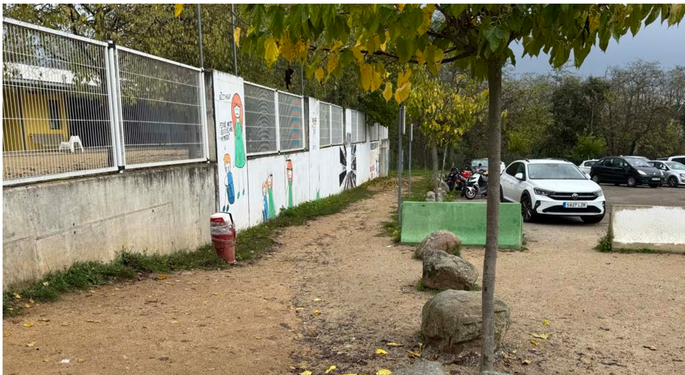
La fotografia mostra la boca contraincendis (hidrant) situat a la part alta de l'accés de vianants a l'escola.
