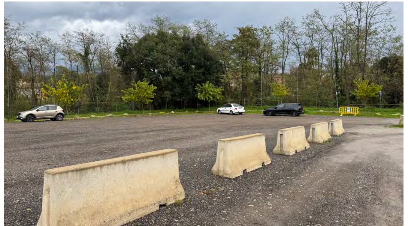
Part final de la zona d'aparcament. Al final de la mateixa es pot observar la línia de rocalla que segrega els vianants de la zona de vehicles. En segon terme s'observen els arbres que marquen el límit amb la Riera de Canyes. Com a la resta de la zona d'aparcament, el paviment està format per materials granulars reciclats tipus formigó i fressat d'asfalt
