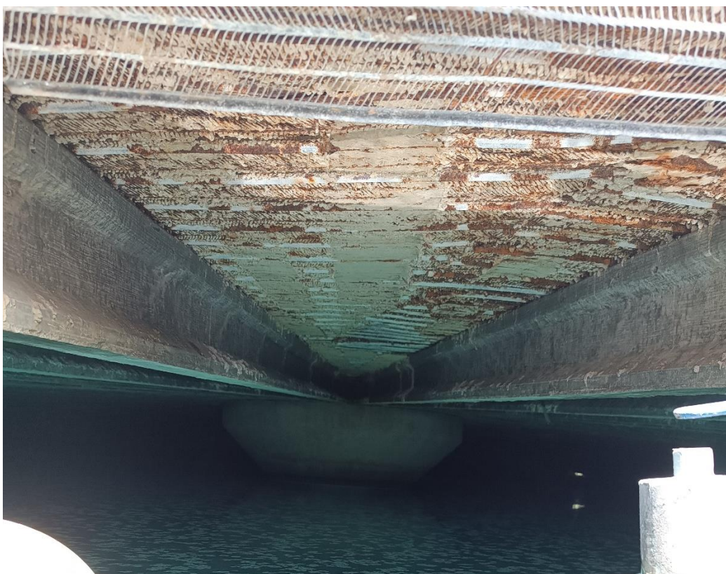
Fig. 3 Vista estructura de la cubierta
