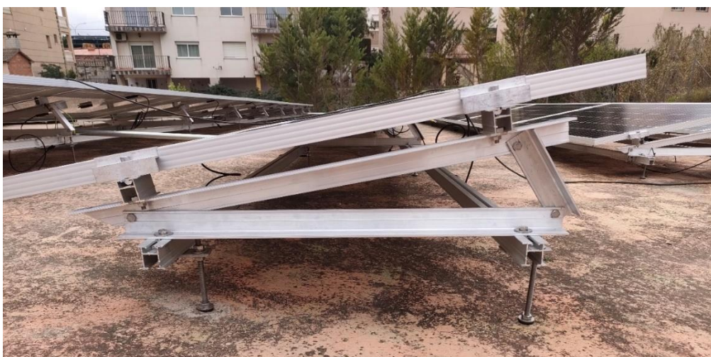
Fig. 5 Exemple de fixació de l'estructura
