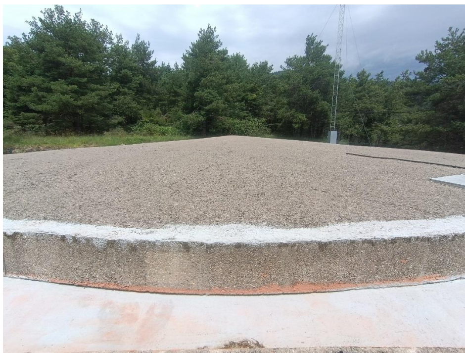
Fig. 2 Vista superior de la coberta cònica
