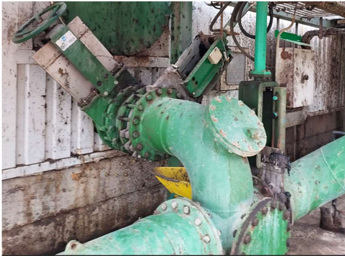
Imagen de la pieza codo-T a sustituir en zona extracción.
