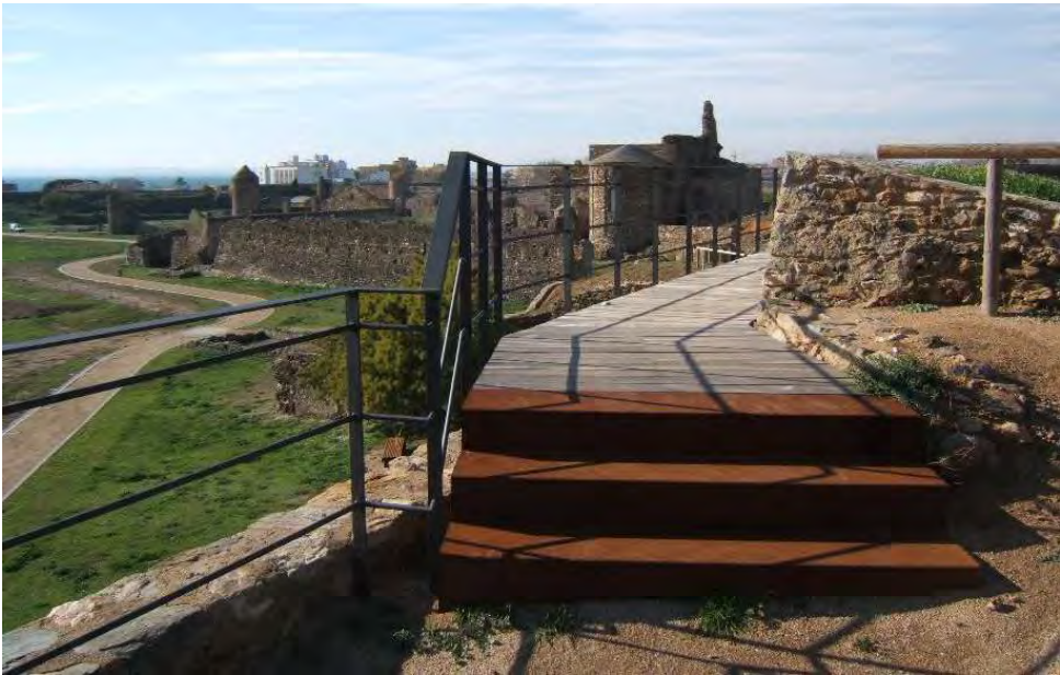
Baluard de Sant Andreu. Proteccions d'acer pintat color gris antracita i barrots horitzontals, paviment de llates de fusta i graons d'acer corten. També apareix la barana provisional de posts de fusta
