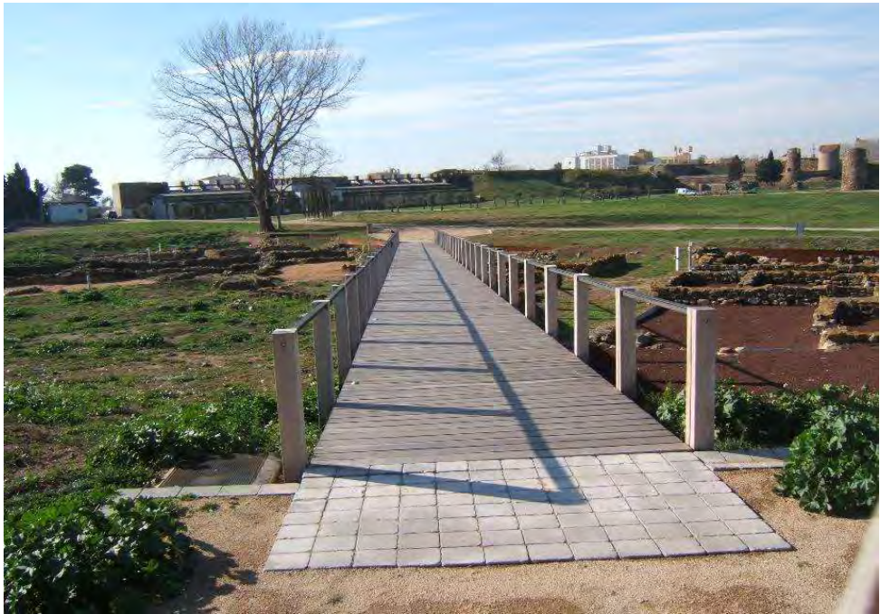
Barri hel·lenístic, passera de suports de posts de fusta, acer pintat gris antracita i paviment de llates de fusta
