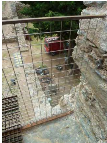
Torre de la muralla medieval interior (2016), d'acer corten i malla electrosoldada d'inoxidable
