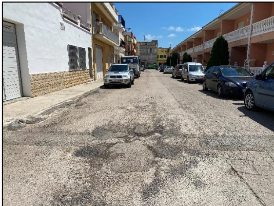
Figura 11. Fotografia actual del carrer del Sol. Font pròpia.
