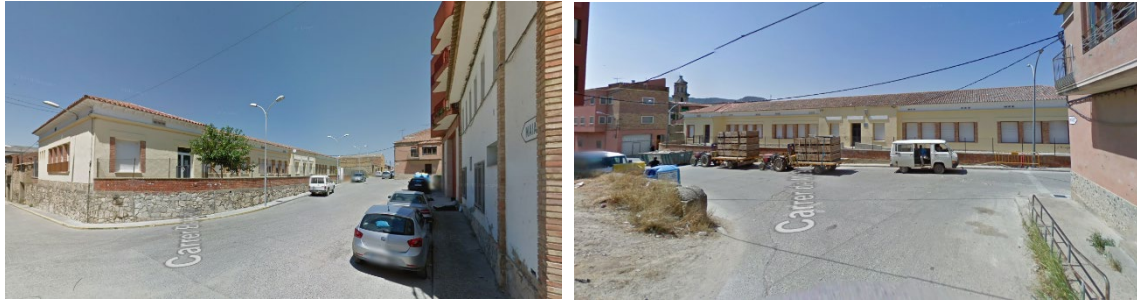
Imatges de l'estat actual del C/Barcelona i cruïlla amb C/ de Maials
