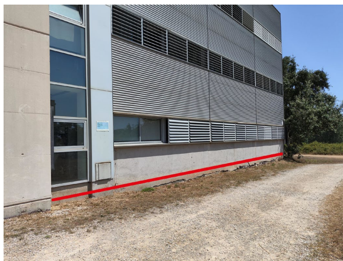
Figura 3 Canalización exterior de la instalación eléctrica y de comunicaciones
