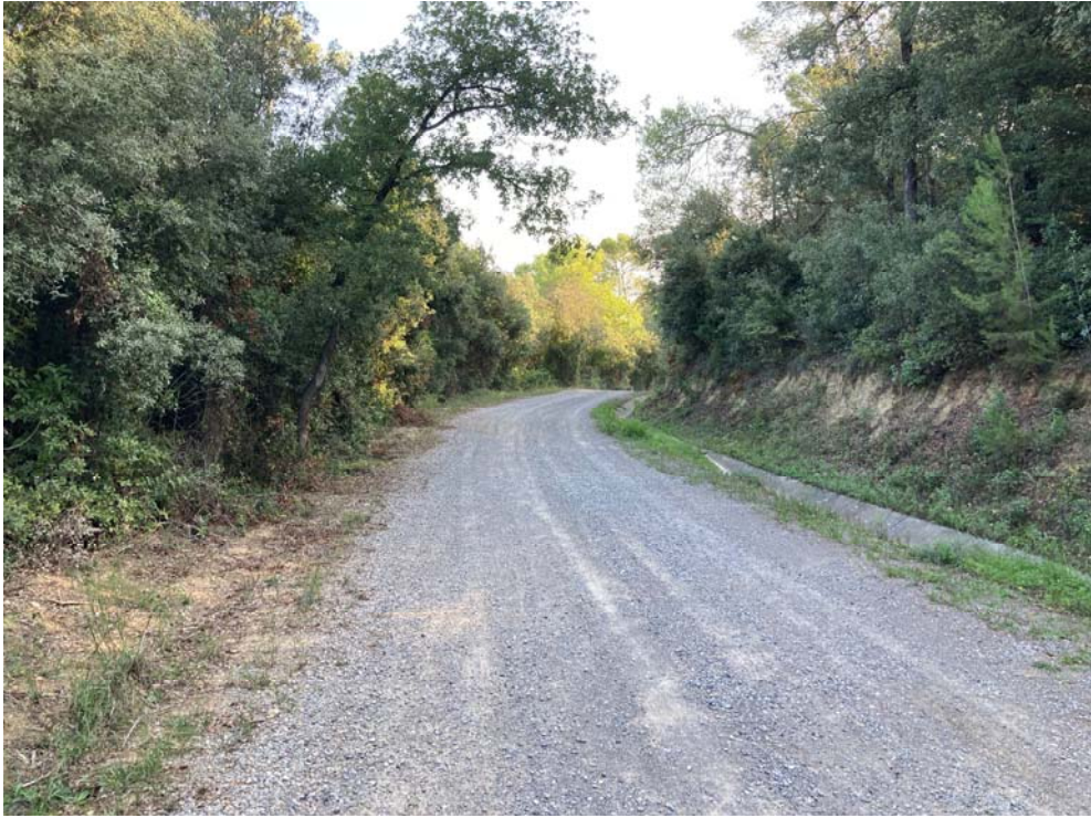
Imatge de l'estat actual del segon subtram del camí, amb cuneta de formigó a la banda dreta, que es proposa pavimentar amb aglomerat asfàltic en calent.
