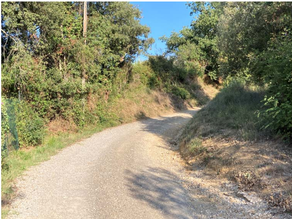
Imatges de l'estat actual del primer subtram del camí, que es proposa pavimentar amb formigó.
