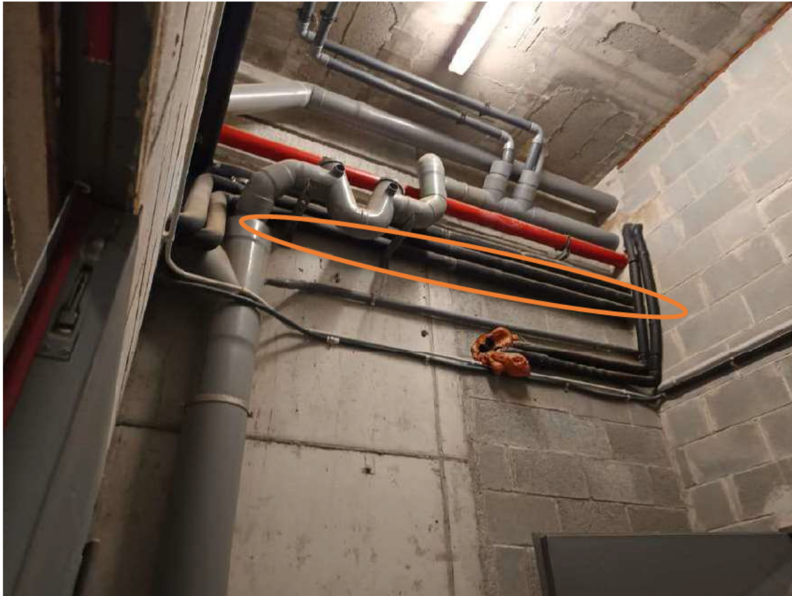
Traçat canonades solars pel vestíbul sala calderes a desmantellar. Traçat canonades solars a eliminar per la sala de calderes fins dipòsit solar
