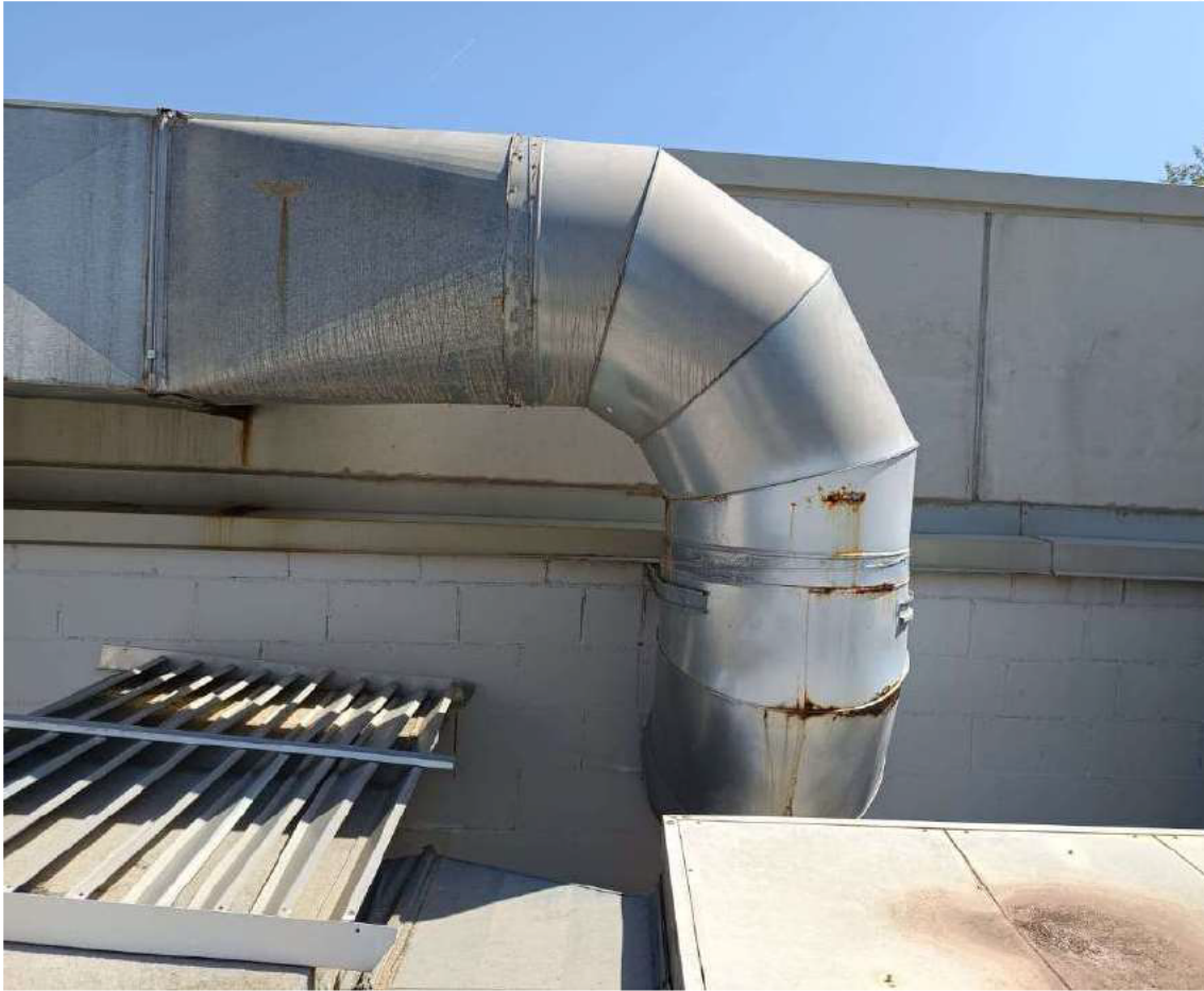
Conducte impulsió 2. Connexió directa amb el recinte piscina. Detall de l'estat del conducte
