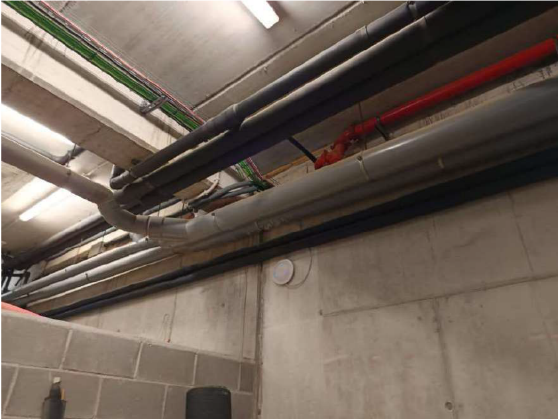
Detall traçat circuit primari caldera-deshumectadora. Les dues canonades de sota són del circuit solar que s'han d'eliminar.
