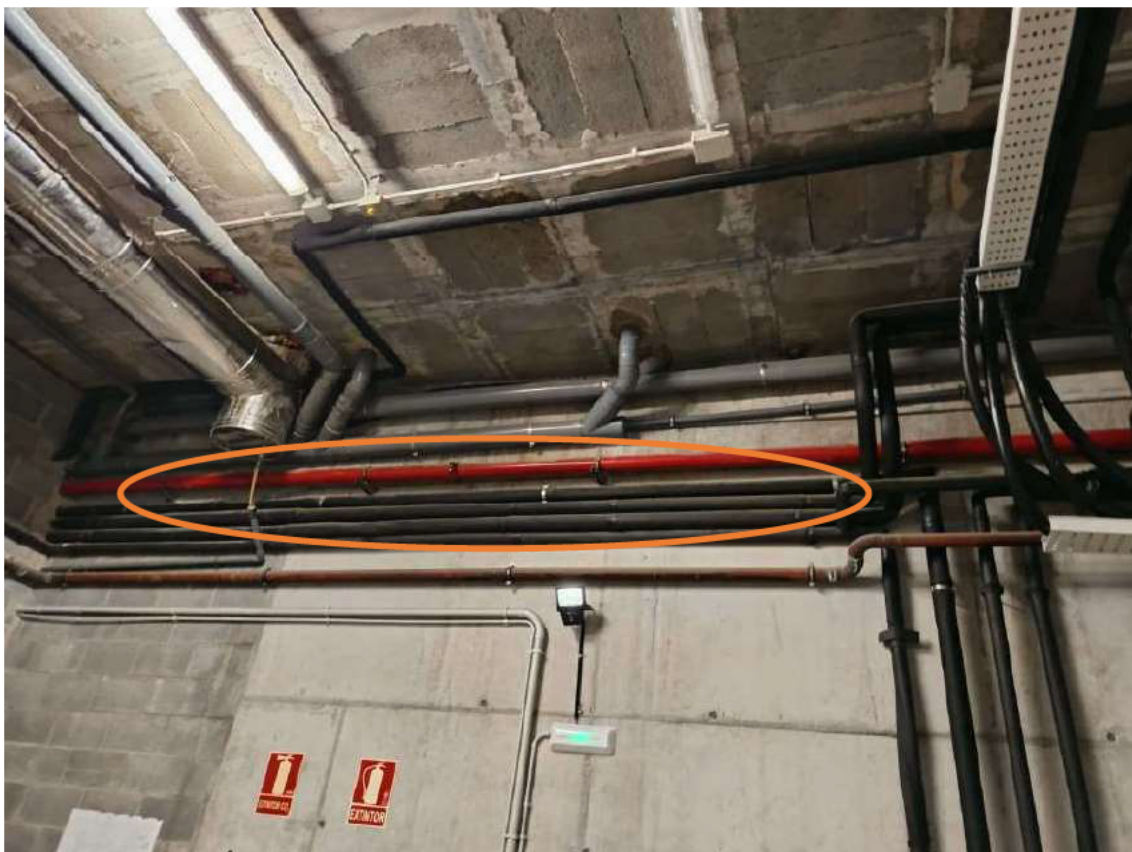
Traçat canonades solars pel vestíbul sala calderes a desmantellar. Traçat canonades solars a eliminar per la sala de calderes fins dipòsit solar
