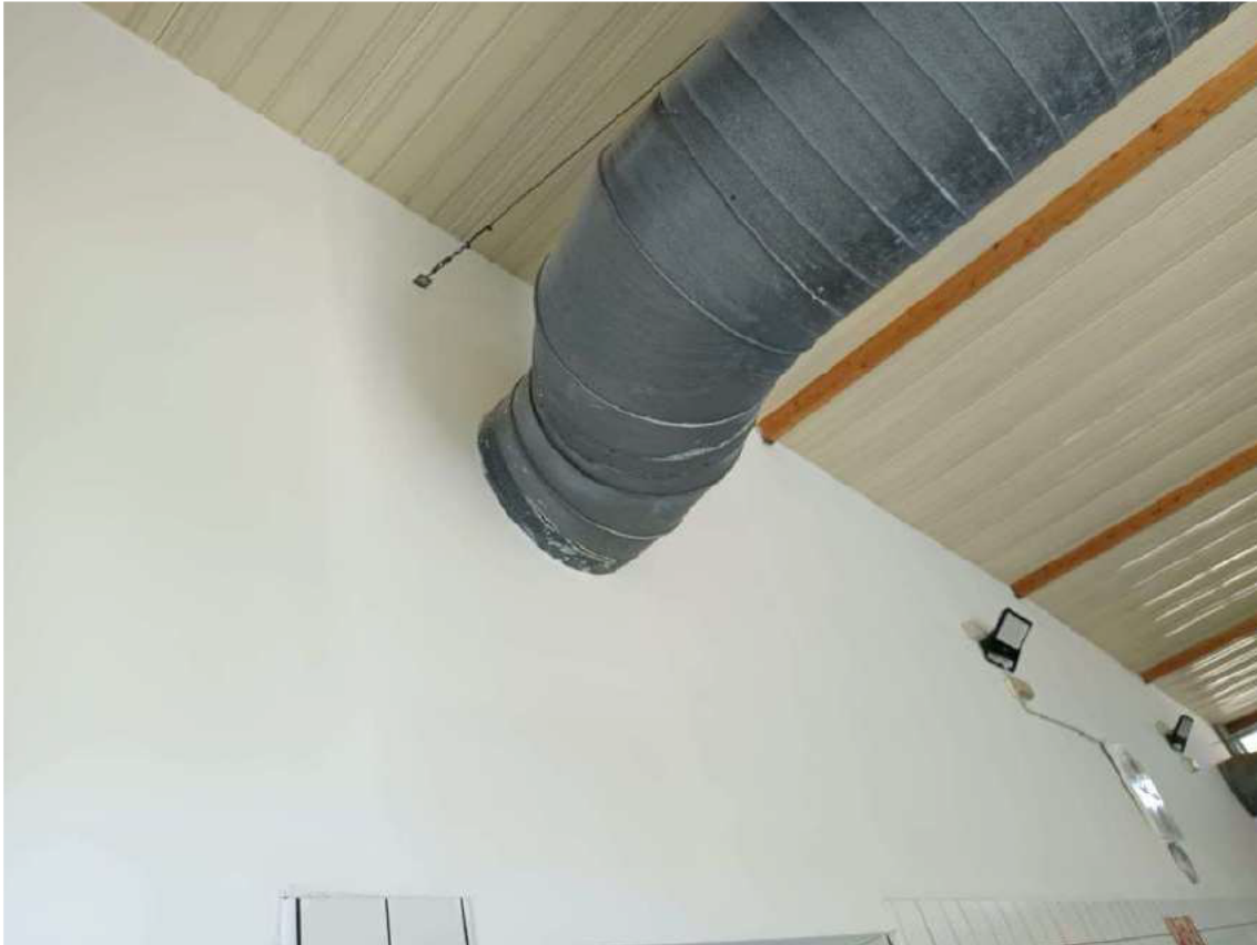
Recinte piscina. Sortida del conducte d'impulsió 2 a nivell de planta primera. Paret que dona a la coberta.
