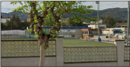
Vista des de l'avinguda Mauri
