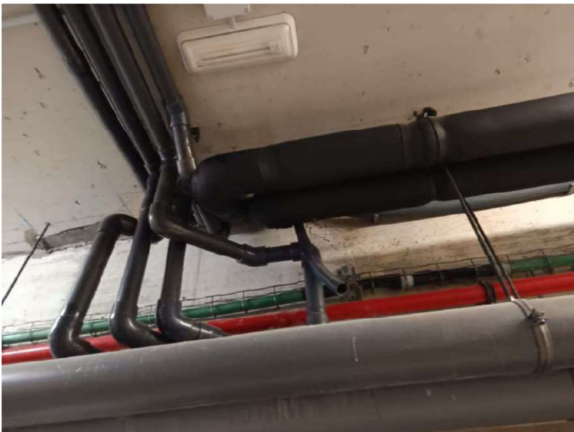
Detall traçat circuit primari caldera-deshumectadora. Les dues canonades de sota són del circuit solar que s'han d'eliminar.
