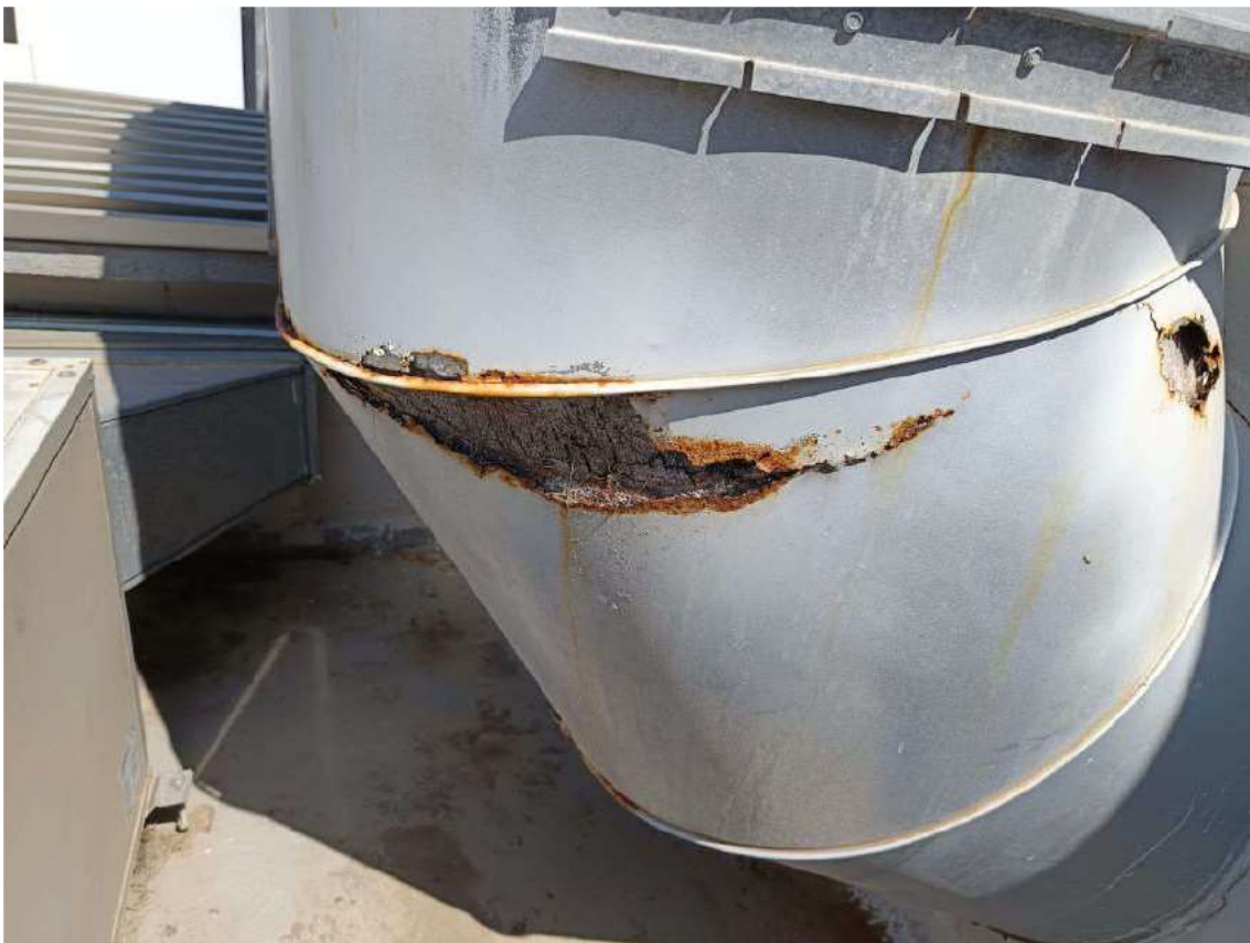
Conducte impulsió 2. Connexió directa amb el recinte piscina. Detall de l'estat del conducte
