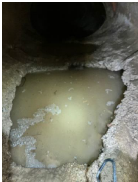
Detall del col·lector aixafat i esquerdat. L'atravessa un piezòmetre
