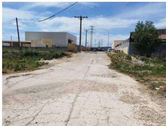
Pas a nivell per sobre del torrent
