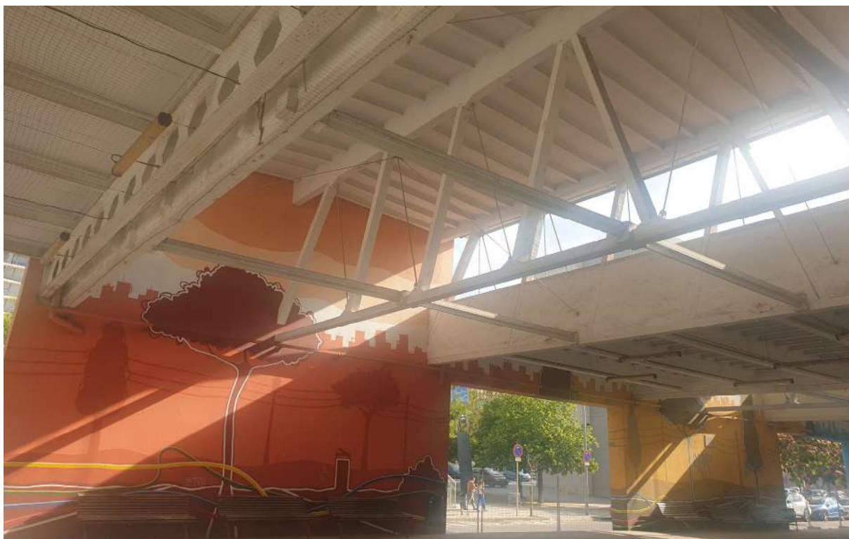
Imatge 2. Cos elevat des de l'interior amb les tres encavallades. Font: Pròpia
