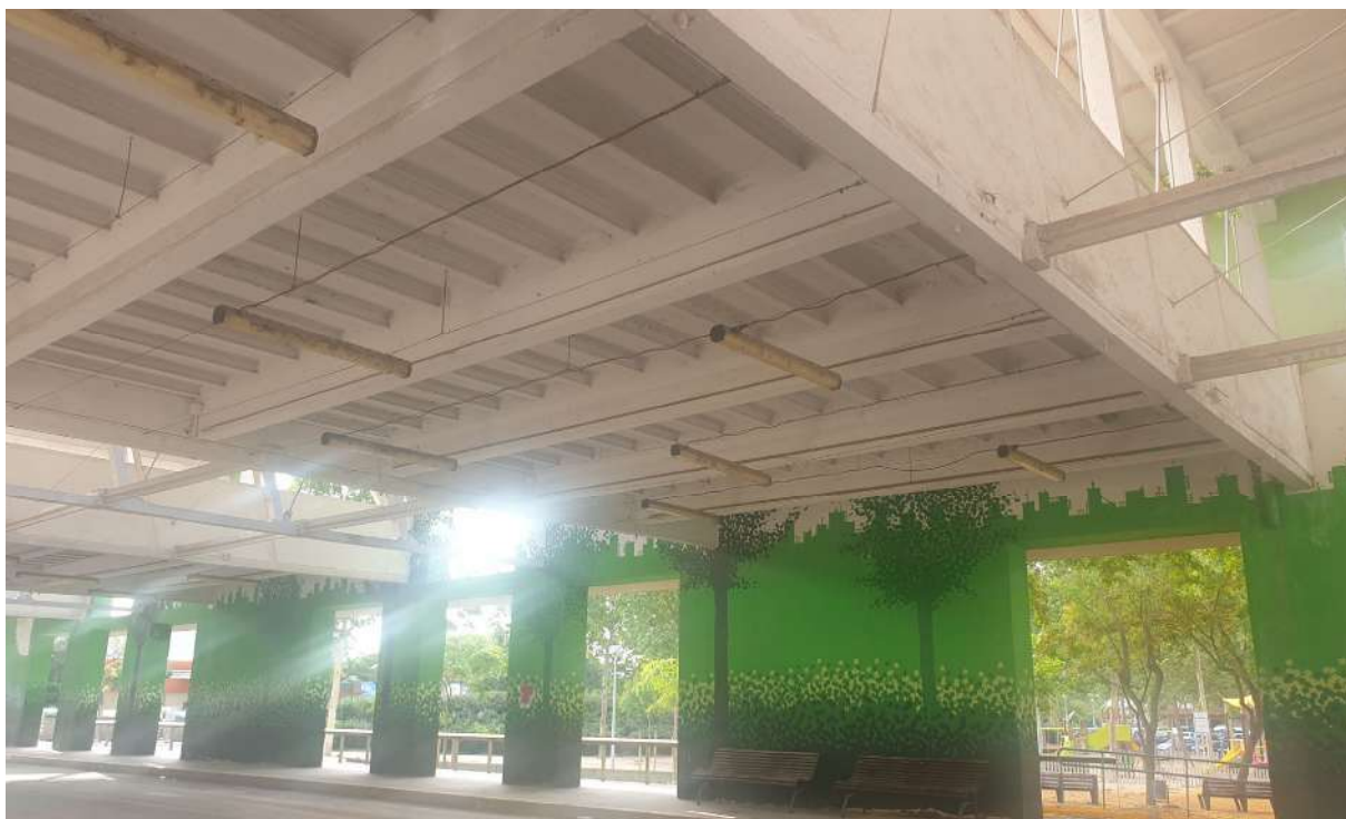
Imatge 4. Cos baix des de l'interior amb recolzament en dues encavallades. Font: Pròpia
