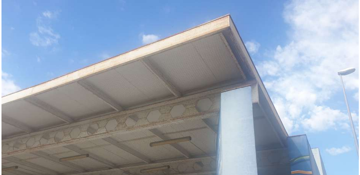
Imatge 5. Coberta afegida en 1995 en la zona est de l'edificació. Font: Pròpia
