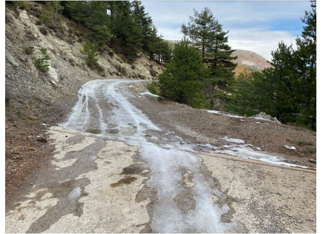
Foto 14. PK 1+184 Final tram paviment de formigó.
