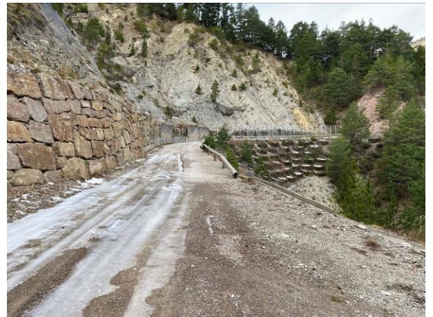
Foto 10. PK 1+100 Inici tram paviment de formigó.
